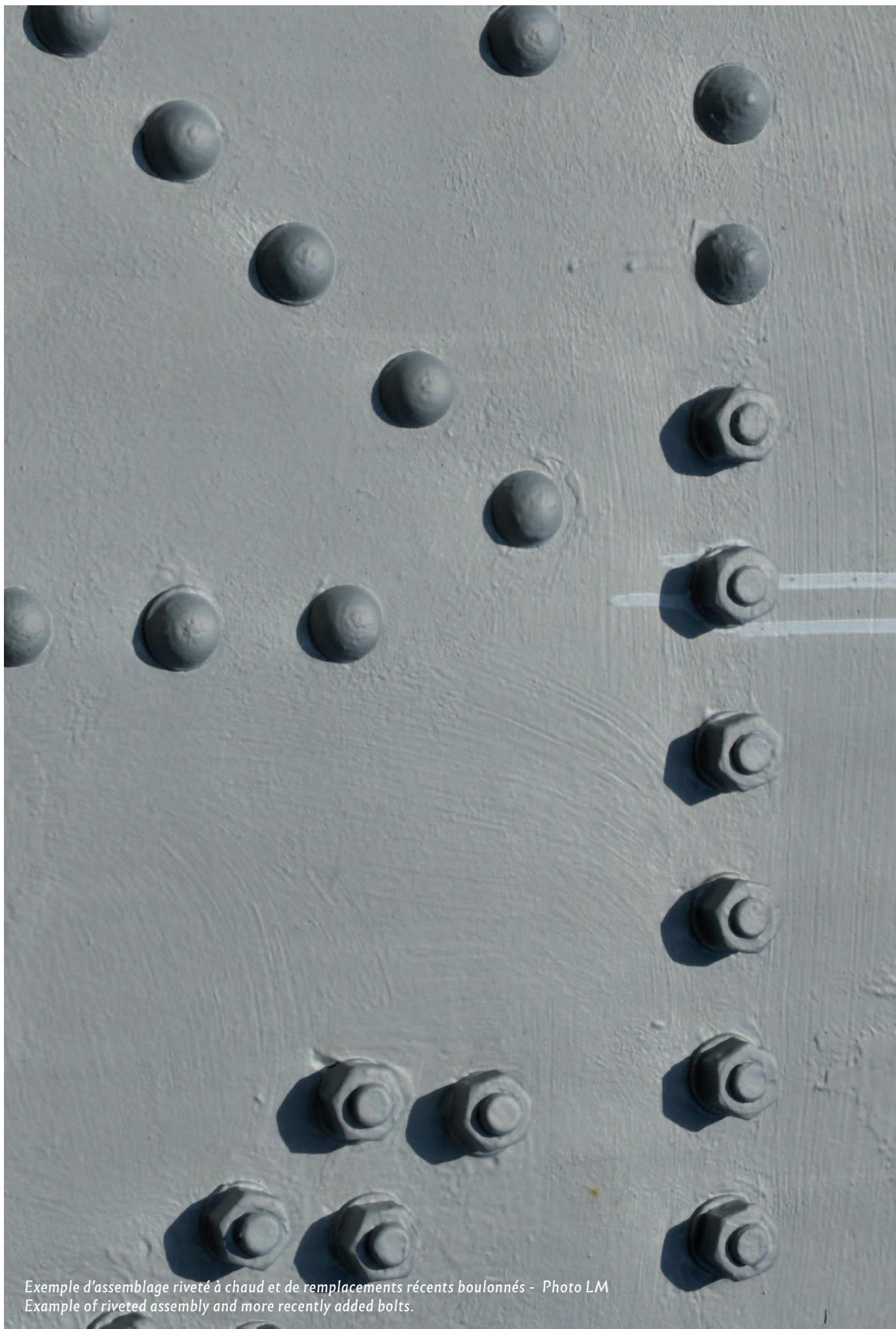
Exemple d'assemblage riveté à chaud et de remplacements récents boulonnés - Photo LM
