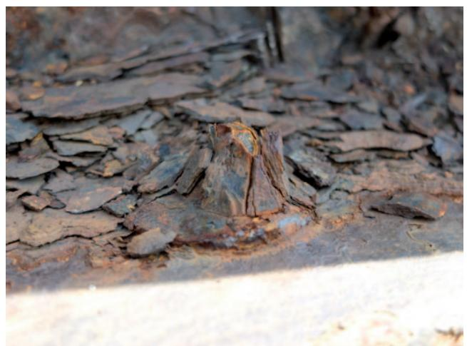
Corrosion avancée des profilés et rivets métalliques - photo LM
