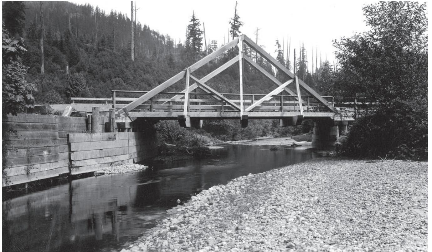
ci-dessus: l'archétype du pont primitif de type "King post", transposition d'une simple charpente
