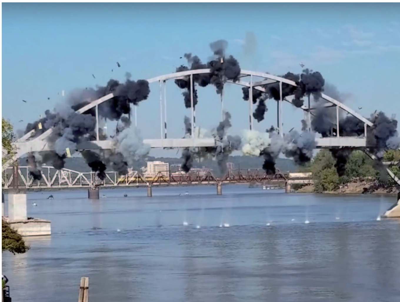
Démolition en 2016 du Broadway bridge sur l'Arkansas River à Little Rock, AR - photo Arkansas Online
