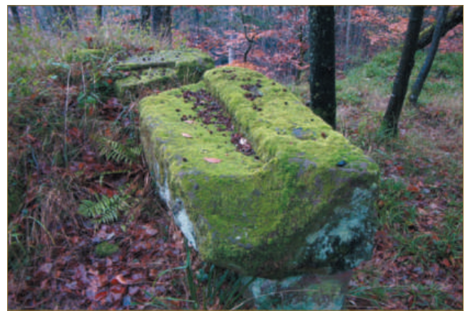
Figure 27 : Le seuil brisé de la porte d'entrée du château (J.-M. Rudrauf).
