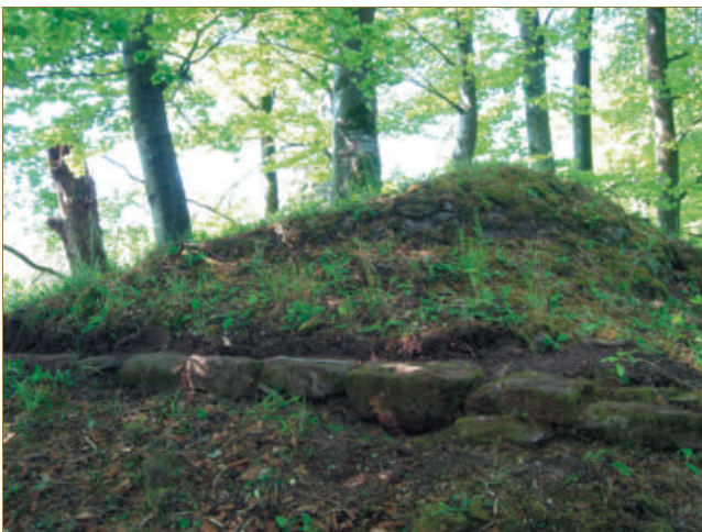
Figure 29 : Seule assise du mur de parement aujourd'hui visible au niveau du monticule constitué par l'effondrement d'un bâtiment turriforme (cliché C. Moulis).
