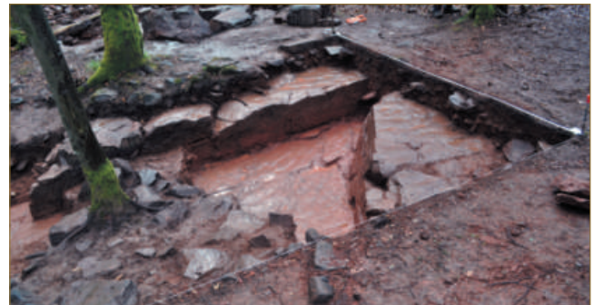
Figure 16 : Carrière sud (unité 2-2001 – cliché C. Moullis).
