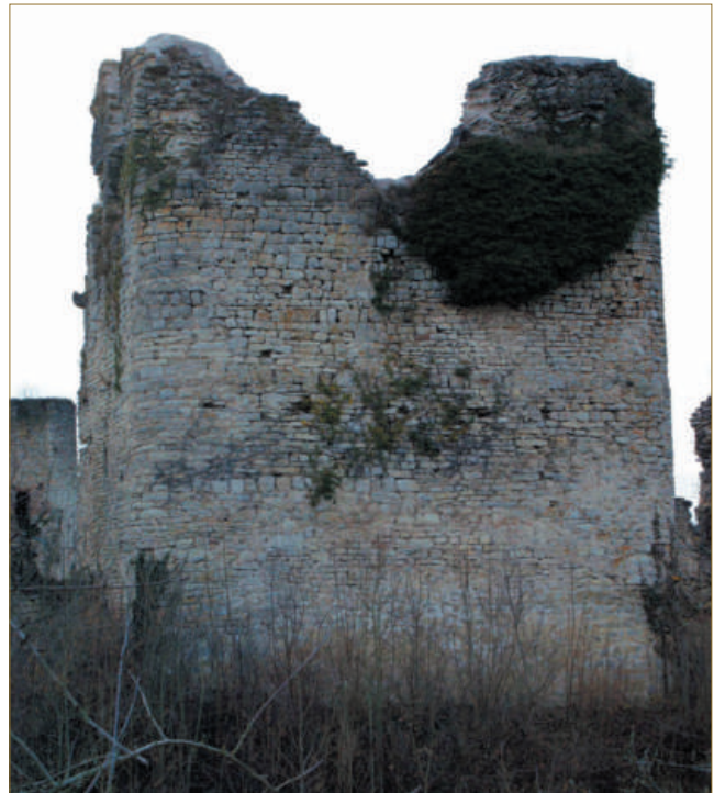
Figure 8 : Face nord-est depuis l'autre côté du fossé (cliché V. Muller).
