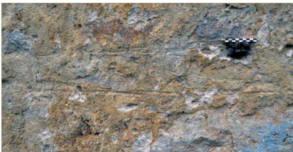
Figure 19 : Joints tirés au fer au bas de la façade nord-est (cliché C. Moulis).
