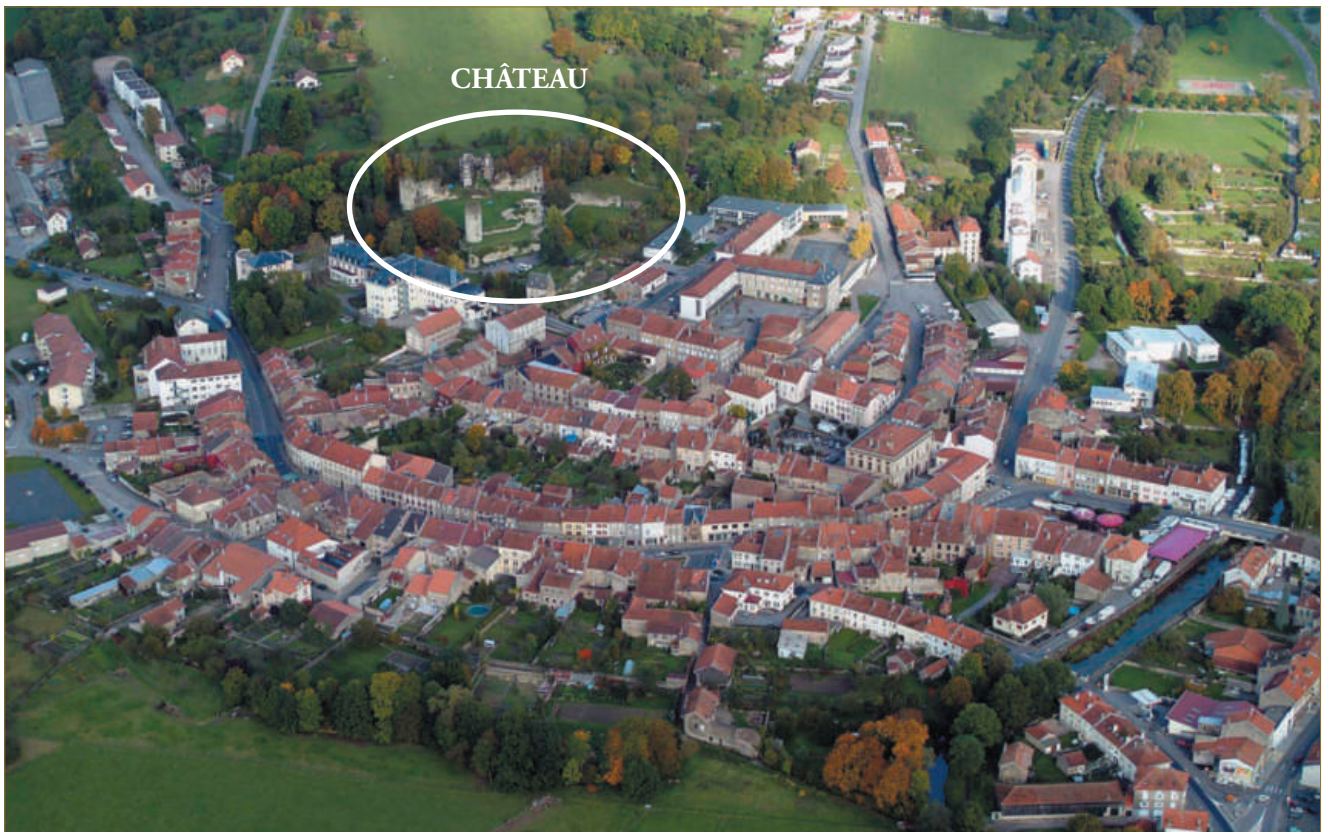
Figure 1 : Vue générale du château et du bourg de Blâmont (Mairie de Blâmont).
