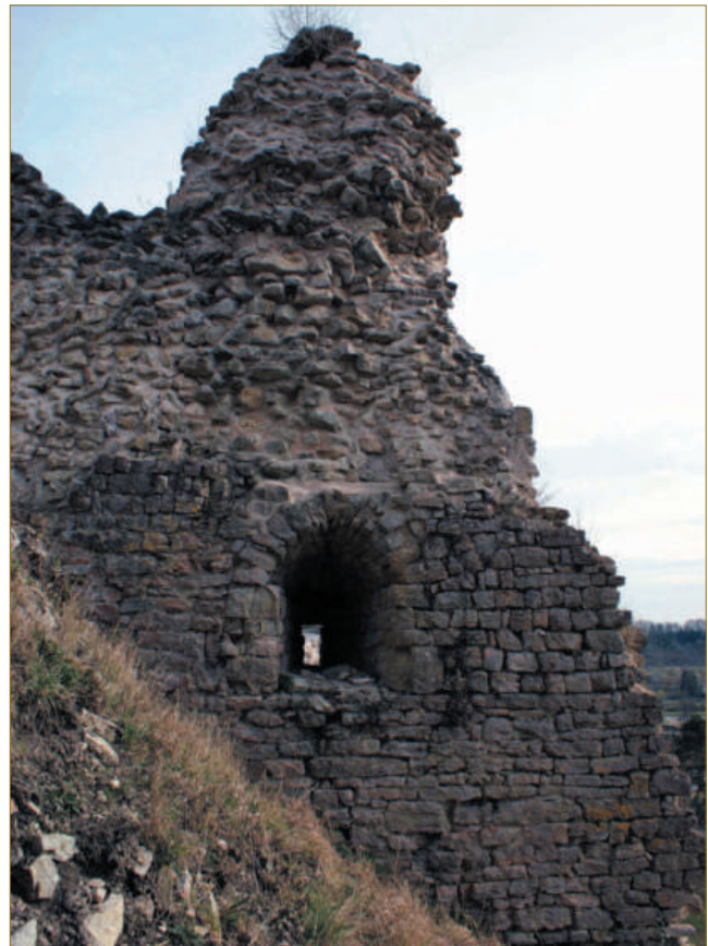
Figure 9 : Intérieur, élévation sud-est (cliché C. Moullis).
