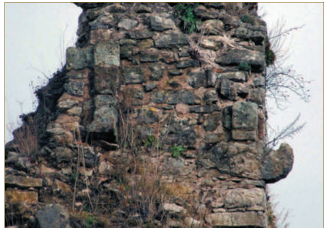
Figure 7 : Porte du donjon. De droite à gauche : corbeau avec crapaudine, première porte, vestibule, seconde porte (cliché C. Moulis).
