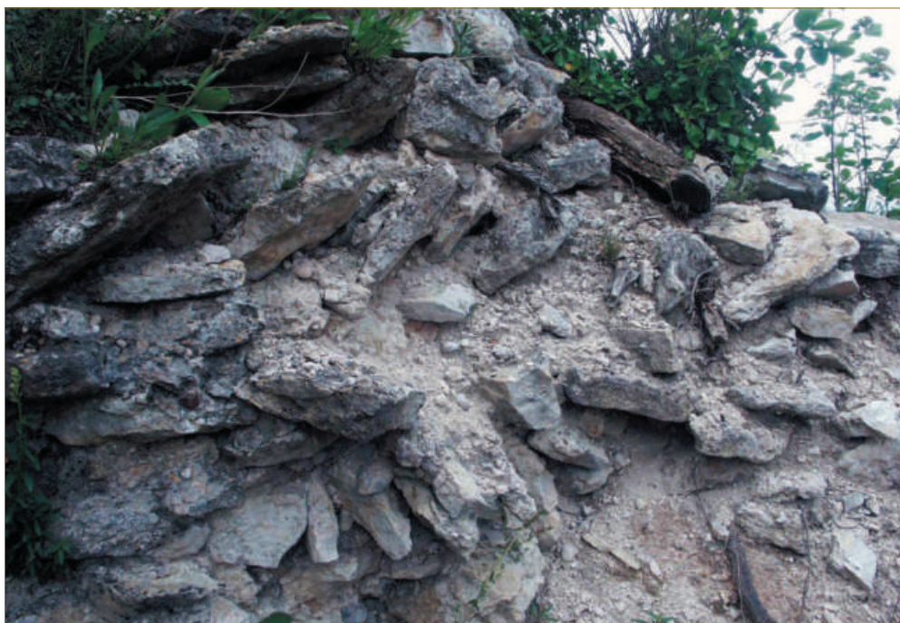
Figure 18 : Blocage en épi au sommet du donjon (cliché C. Moulis).
