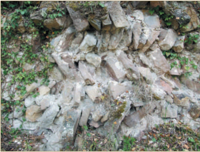
Figure 12 : Blocage du mur nord-est, disposé en épi (cliché C. Moulis).
