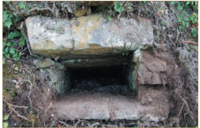
Figure 5 : Puits de lumière de l'élévation nord-est (cliché C. Moulis).
