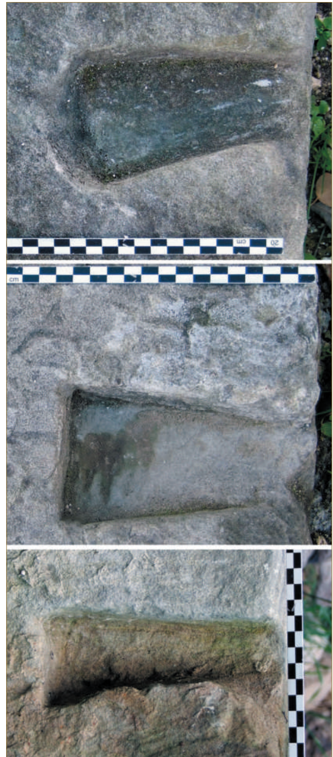
Figure 11 : Encoches en queue d'arronde retrouvées sur les pierres du parement à l'angle nord (clichés C. Moulis).
