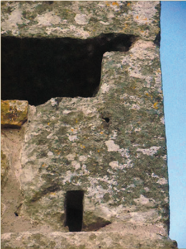
Figure 21 : Vue de la face sud-ouest du bloc n°4 et de l'anche de pince articulée (cliché K. Boulanger).
