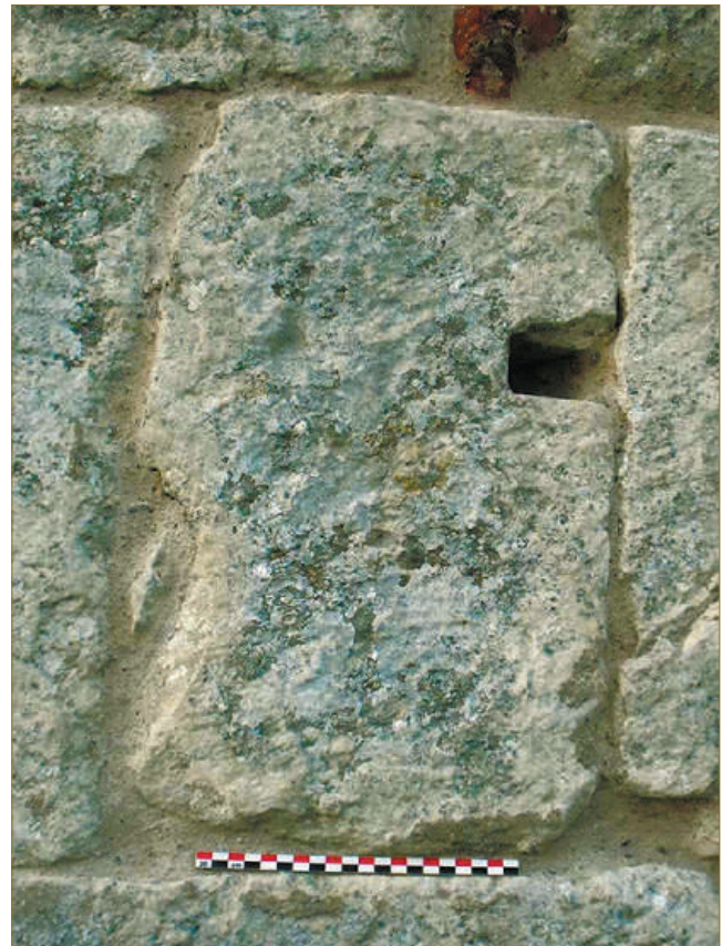
Figure 19 : Vue de la face sud-est du bloc n° 3 (cliché K. Boulanger).
