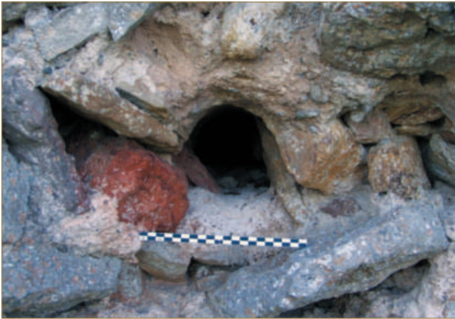
Figure 31 : Trou de boulin circulaire (cliché C. Moulis).
