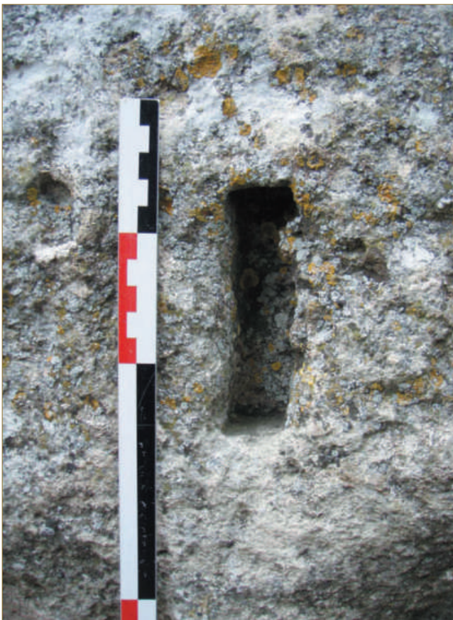
Figure 17 : Vue de détail du trou de louve du bloc n°2 (cliché K. Boulanger).
