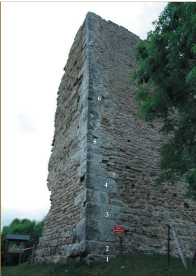
Figure 13 : Vue du chaînage d'angle sud avec l'indication des blocs antiques en remploi (cliché et DAO K. Boulanger).
