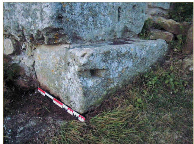
Figure 15 : Vue de l'angle sud du bloc n° 1 (cliché K. Boulanger).
