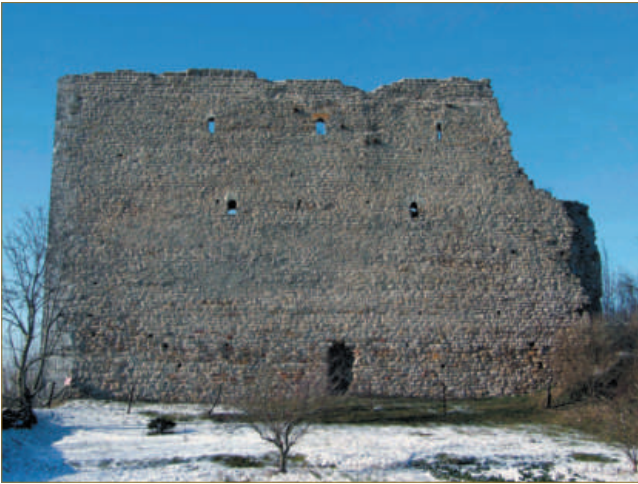
Figure 3 : Élévation extérieure est du donjon (cliché C. Moulis).
