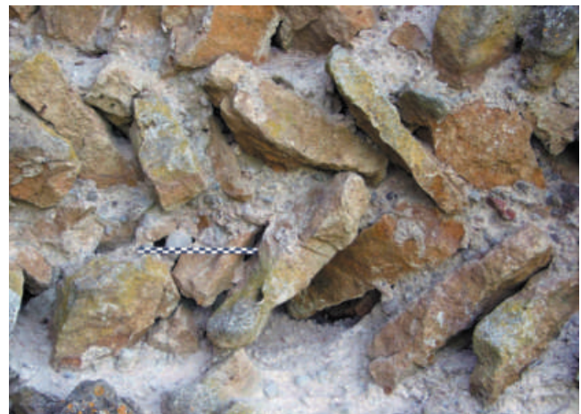
Figure 28 : Détail du blocage en épi (cliché C. Moulis).
