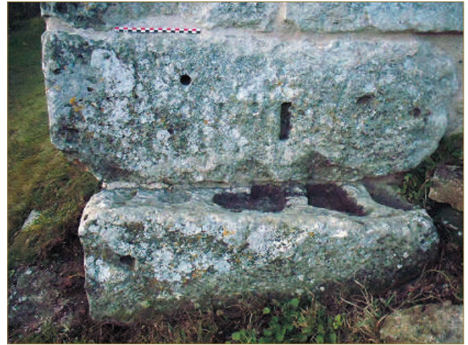
Figure 14 : Vue des blocs n° 1 et 2 remployés à la base du chaînage d'angle sud (cliché K. Boulanger).
