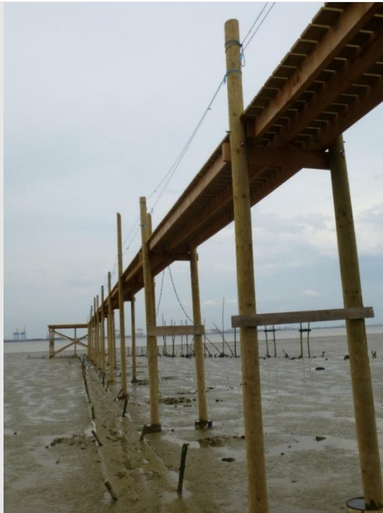
Passerelle de pêcherie APSE en cours de construction sur l'estuaire de la Loire, Corsept (Loire-Atlantique) © Anatole Danto.
