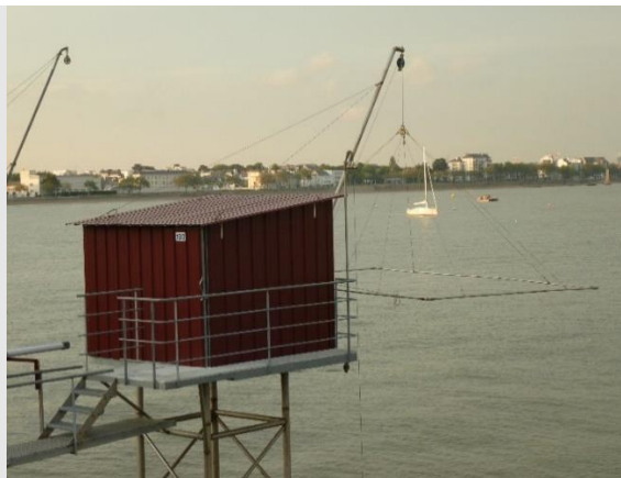
Pêcheries de l'estuaire de la Loire, avec le filet fixé à l'extrémité de quatre perches et avec le filet attaché à un cadre carré, Saint-Nazaire (Loire-Atlantique) © Anatole Danto.
