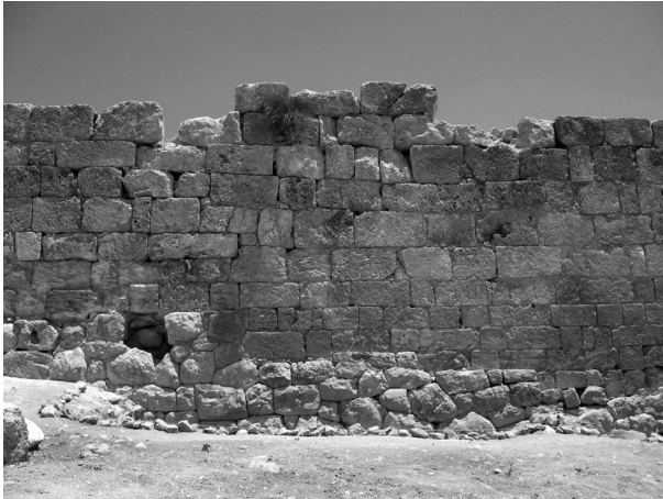
Fig. 2: Courtine 2-3, au niveau du sondage Frézouls 2. A partir du 2e bloc polygonal à droite de la cavité, on distingue une césure verticale dans l'élévation.
