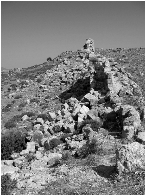
Fig. 3: Courtine 2-3, vue vers l'ouest. L'intérieur de la citadelle est à droite.
