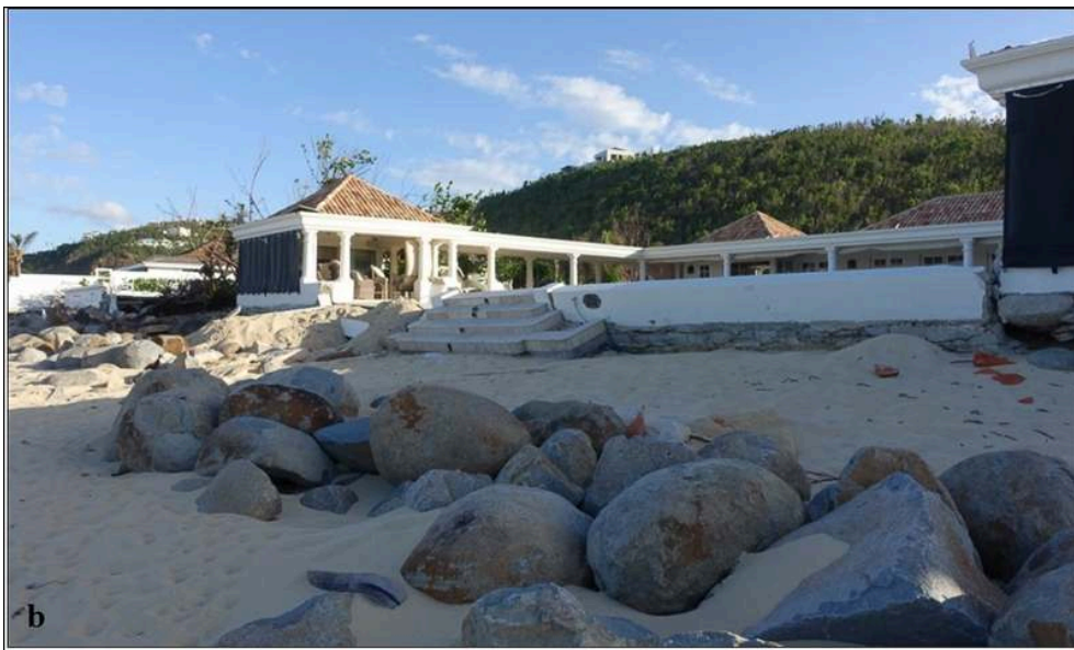
Illustration 5b - Impacts de l'ouragan Irma sur les bâtiments et les infrastructures côtières : murs effondrés sous l'effet de l'érosion verticale
