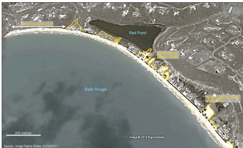
Illustration 8a - Impacts morphologiques de l'ouragan Irma à Baie Rouge (St Martin) : formation de washover et dommages sur les murs de clôture
