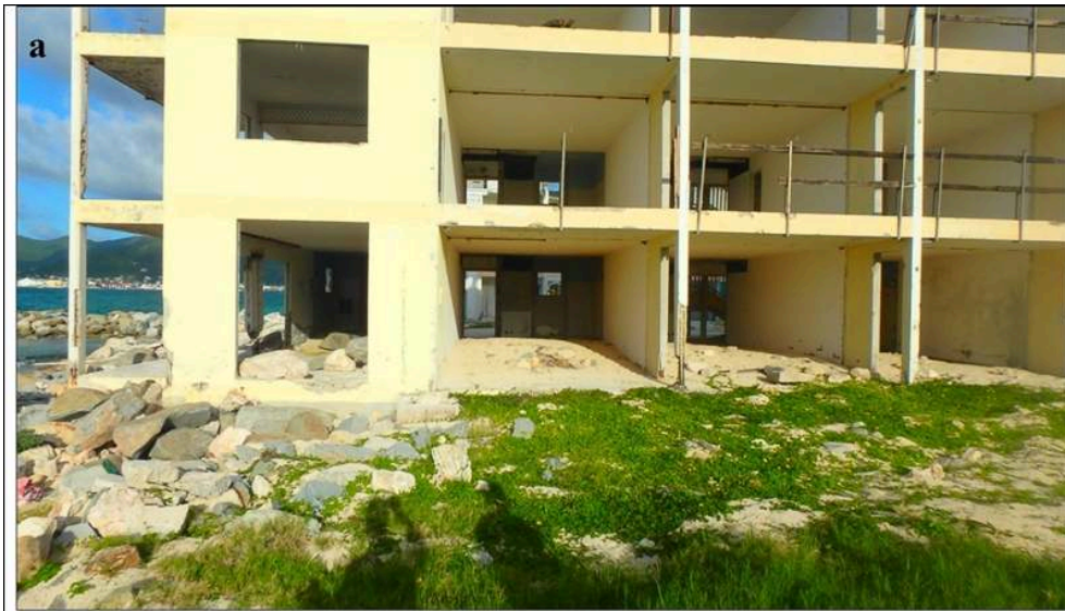
Illustration 7b - Matériaux transportés par les vagues cycloniques : enrochements déplacés par les vagues cycloniques
