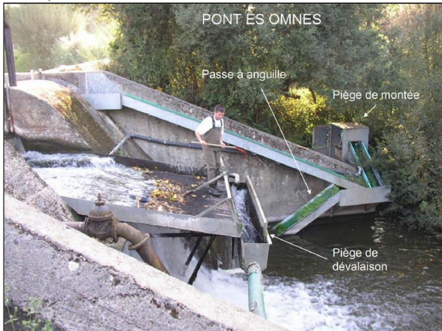
Figure 9. Passe et pièges sur le barrage de Pont Es Omnes (Charrier *et al.* 2014)
