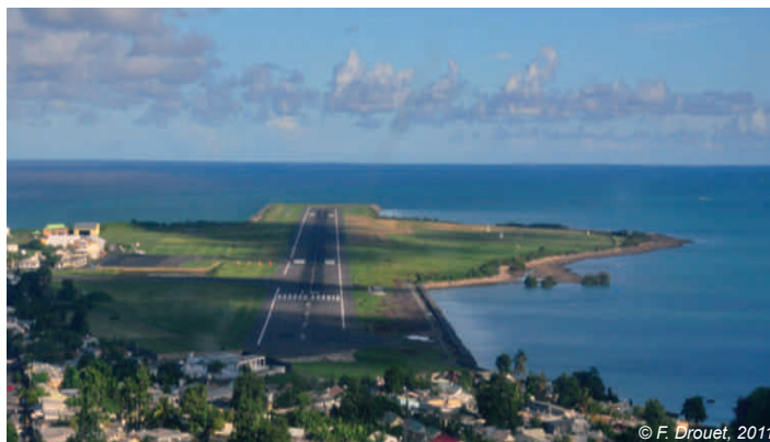
L'aéroport est une des ressources extérieures très exposée au risque de submersion marine
