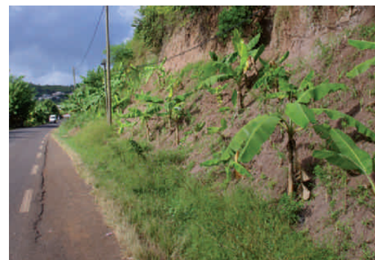
Plantation de bananiers pour fixer les talus
