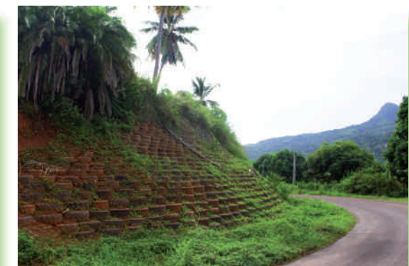
Mise en place de pneus qui maintiennent le versant
