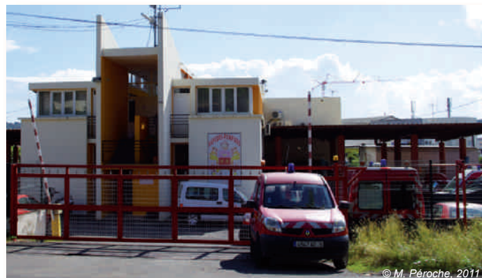
Le Service départemental d'incendie et de secours de Mamoudzou. Bien que non inondable, il peut être totalement isolé en cas de tsunami.
