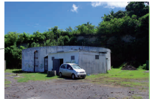
Réservoir sur la commune de Pamandzi situé en zone d'aléa mouvements de terrain. La remise en service d'un réservoir peut aller d'une journée à un mois suivant sa taille
