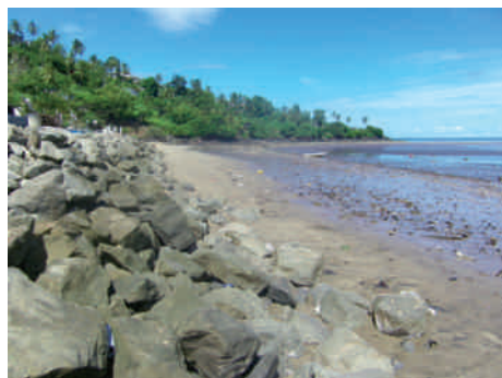
Enrochements sur le haut de plage
