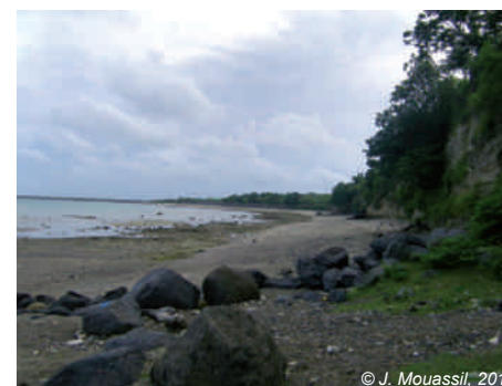
Blocs éboulés sur la plage au pied des falaises (côté sud)
