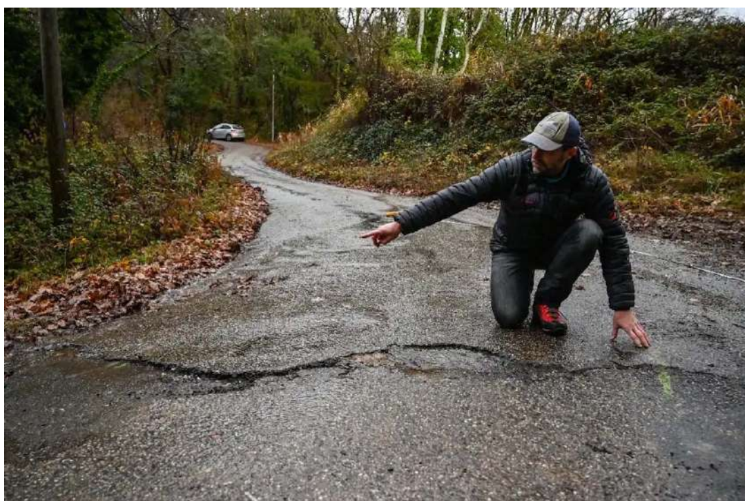
Ruptures de surface observées après le séisme du Teil. La rupture de surface à la suite du séisme du Teil, visible ici à travers l'asphalte d'une route, fait environ 4 m de longueur. Le compartiment situé sous la personne a été soulevé de quelques centimètres. Philippe Desmazes/AFP
