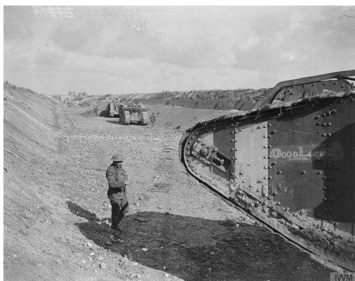
Figure 1. La tranchée du canal du Nord pendant la bataille en septembre 1918. Crédit David McLellan.
