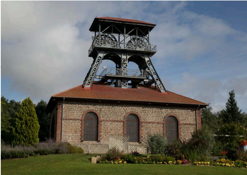
Figure 9. Le chevalement du puits du Marais au Chambon-Feugerolles
