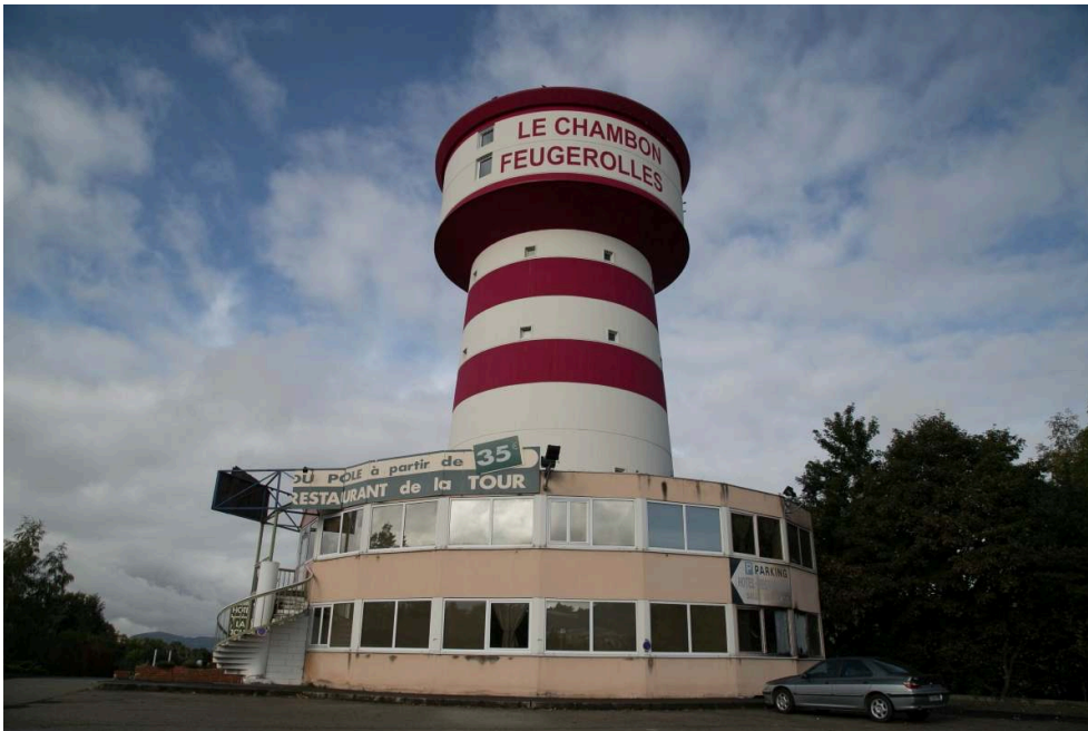
Figure 8. Le château d'eau de la cokerie de La Silardière au Chambon-Feugerolles
