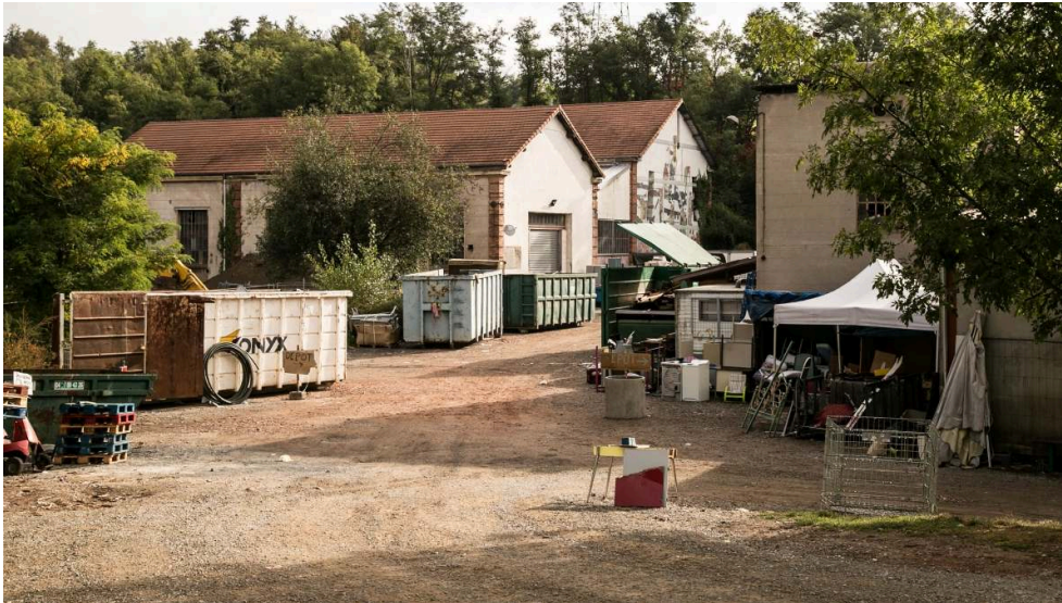
Figure 7. Le site du Puits Cambefort à Firminy
