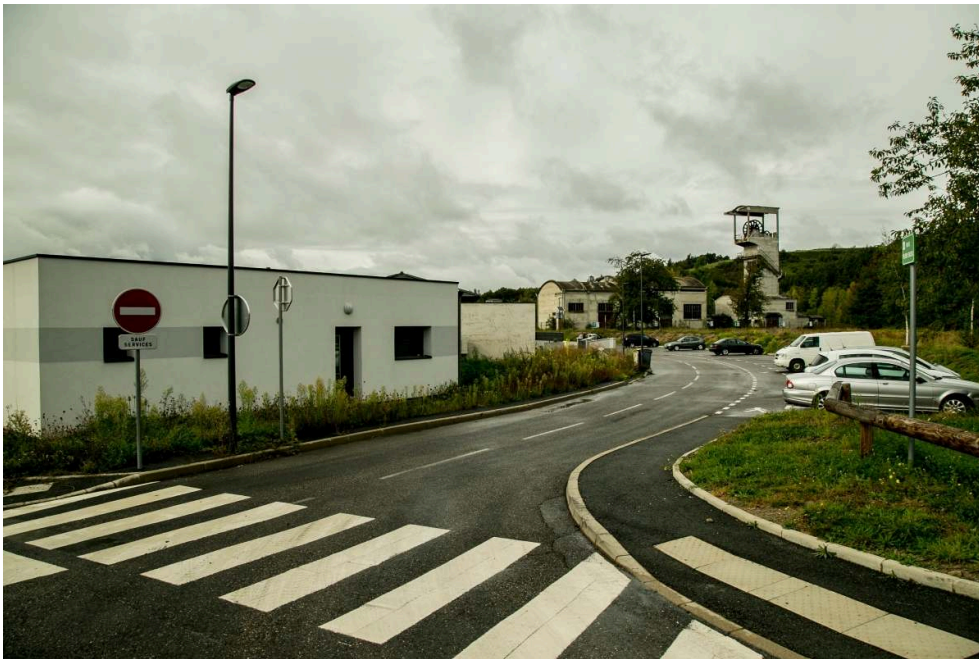
Figure 4. Le chevalement du puits des Combes à La Ricamarie
