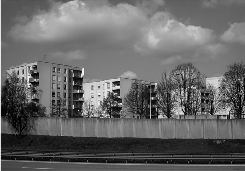
Photographie 1 — Strasbourg, le grand ensemble d'habitat collectif de Haute-pierre, construit à partir de 1969. Auteur : Aliénor Heil- Sélیمانovski, mars, 2006.
