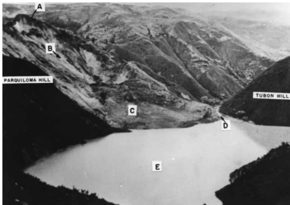
Figure 63 : Vue du glissement et du lac formé par le barrage du Rio Paute. (Photo C. Menéndez).
