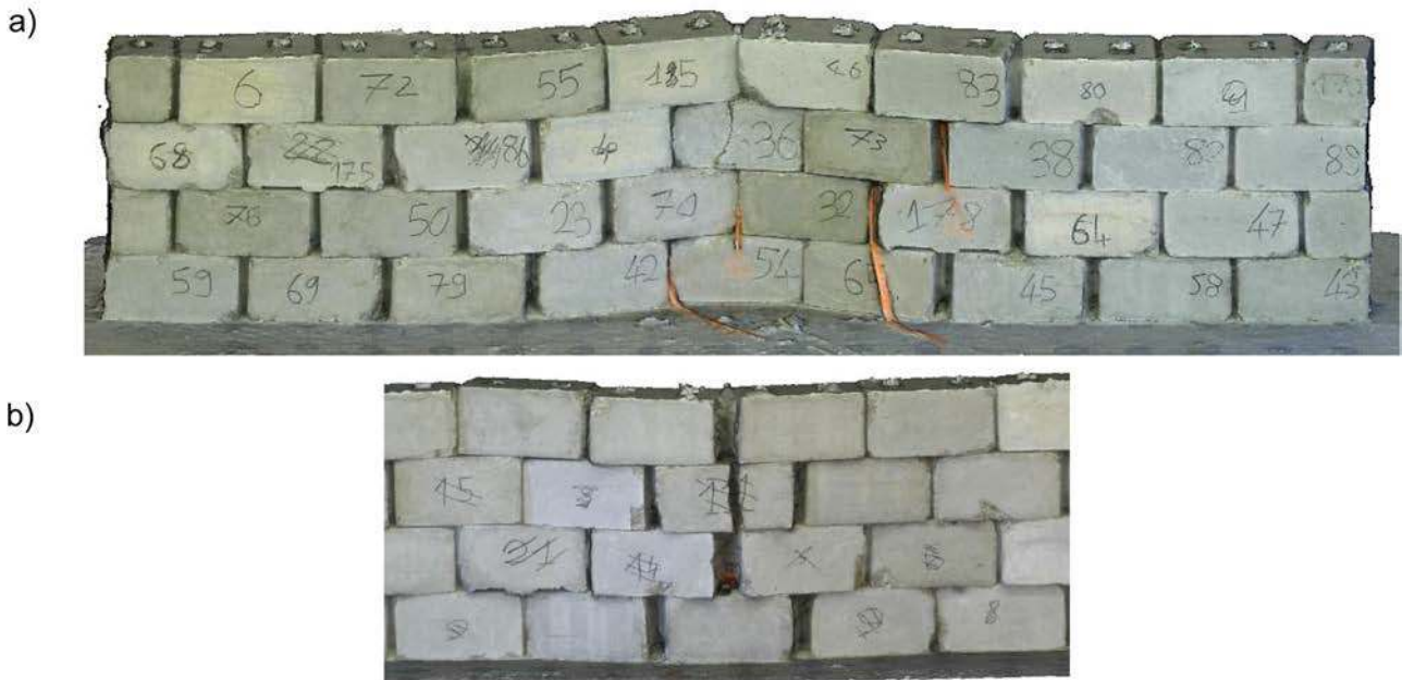
Fig. 5. Mur droit après impact à 1040 J pour H_i=0,5 m (a) déformation générale du mur ; (b) état du mur à l'arrière. Fig. 5. Straight wall after a 1040 J impact at H_i=0.5 m (a) wall deformation; (b) back face of the wall.
