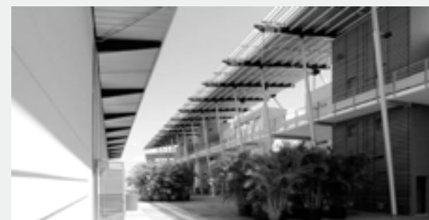
Fig. 7 : Les locaux de l'antenne de l'ENSAM au Port, qui abritent aussi l'École supérieure d'art, 2002, Architecture-Studio arch (ph. Hervé Duris).
