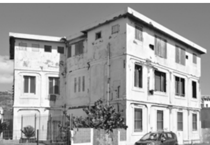
Fig. 6 : L'ancien Centre technique interprofessionnel de la canne à sucre à Saint-Denis, qui a abrité l'antenne à La Réunion de 1988 à 2002 (ph. Éric Lejoyeux).
