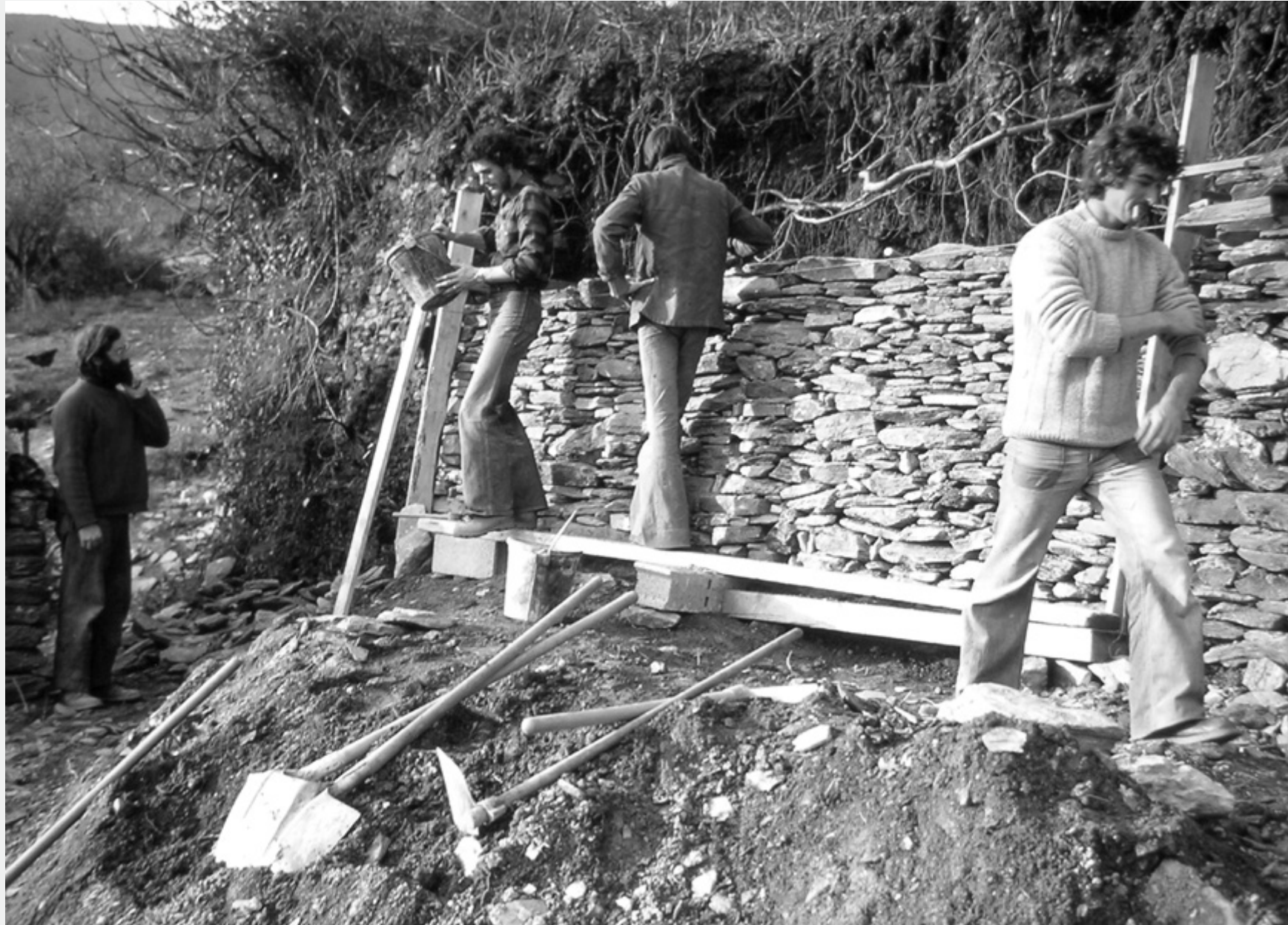
Fig. 3 : Architecte, agent de développement : savoir-faire et matériaux locaux. Chantier pierres sèches à Génolhac, avec Roland Mousques. Coll. N. Chautard.
