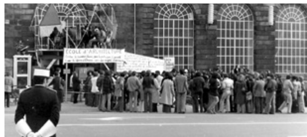
Fig. 2 : Installation sauvage d'une salle de classe accolée à la halle aux blés pour dénoncer les mauvaises conditions d'enseignement. Photographie, novembre 1977, coll. part.
