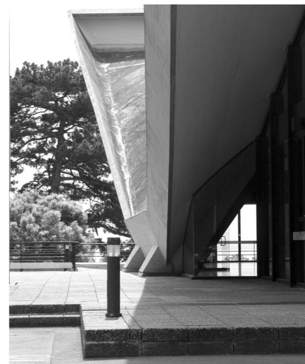
Fig. 3. : Aula de l'École polytechnique fédérale de Lausanne, 1961-1962, Jean Tschumi arch. Détail du voile de béton armé. Wikimedia commons, cliché Port(u)°s, 2008, CC BY 3.0.
