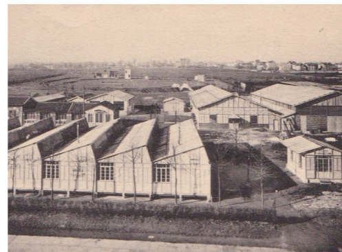
2. Les installations de l'école d'application à Arcueil-Cachan avant 1914. Le bâtiment au premier plan à droite est affecté à l'atelier d'architecture. Au fond « le polygone » d'exercice et son train électrique. Extr. brochure ESTPBI, Levallois-Paris, H. & J. Tourte, [ca 1908].
