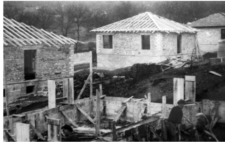
3. Chantier de maisons castors par les ouvriers de la Compagnie des forges de Châtillon-Commentry et Neuves-Maisons, à Chavigny (1953) avec Jacques et Michel André. Archives privées.
