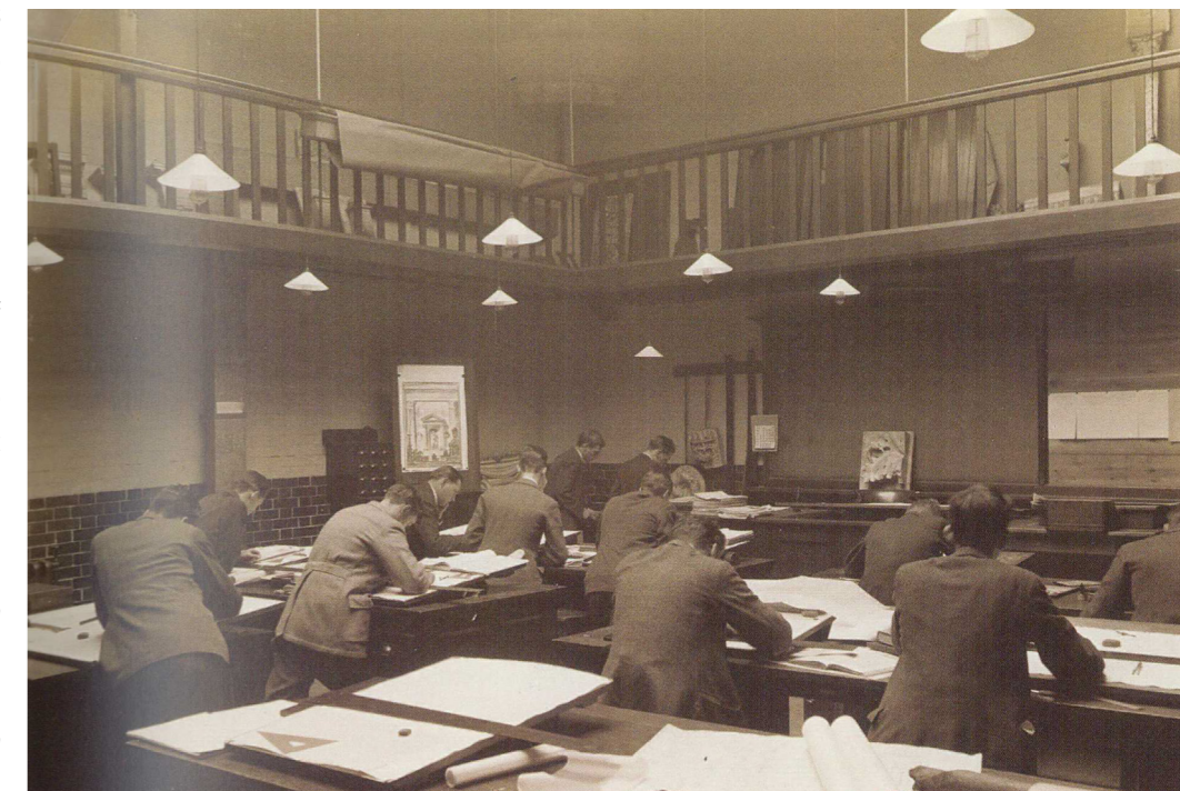
2. L'école de Sheffield dans ses premiers locaux ; la pièce en galerie dans la tour de Firth Court (Sheffield University Archives).
