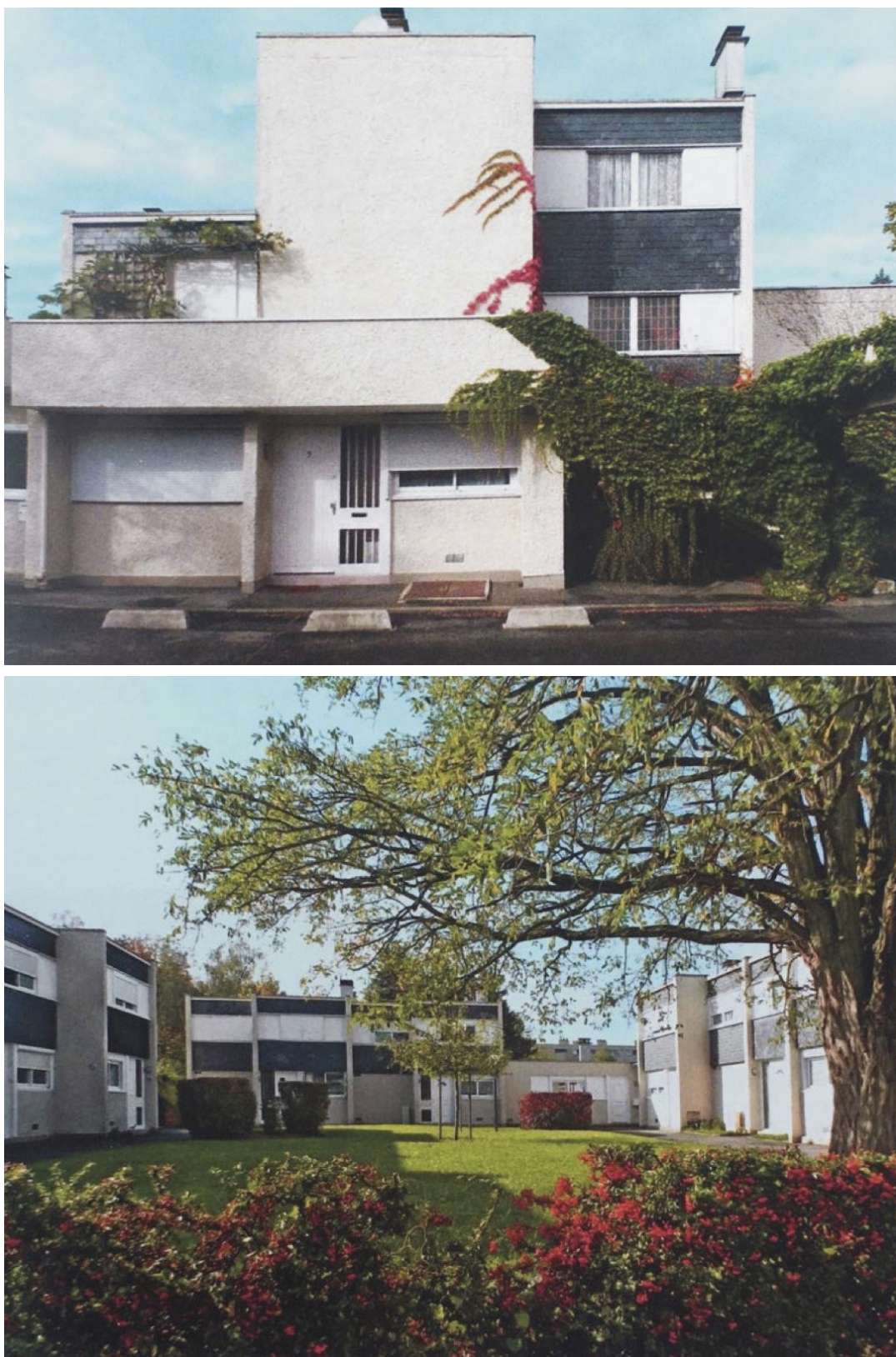
Fig. 5: Photographies de l'opération « Clos Guillaume » de Jacques-Henri-Labourdette située à Epinay-sous-Sénart. Cette opération, réalisée entre 1969 et 1971, est composée de 64 logements intermédiaires disposées en rangées décalées autour d'un espace vert.
