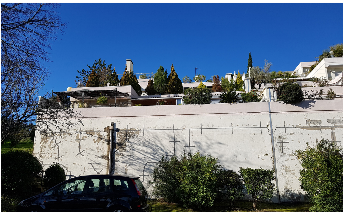
Fig. 18 : Exemple d'altérations au Collet des Comtes
