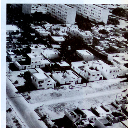
Lotissement d'État (en chantier) Prix de vente d'un lot de 65 m 2 équipé (égout, eau, électricité) 200 000 à 250 000 F (à crédit en 10 ans) Prêts 150 000 à 250 000 F
