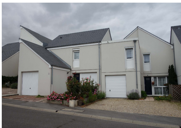
Fig. 11 : Modèle Innovation Villages de l'Ouest, Pierre Prunet, Alain Garat architectes, Laon Source : © Caroline Bauer, septembre 2019
