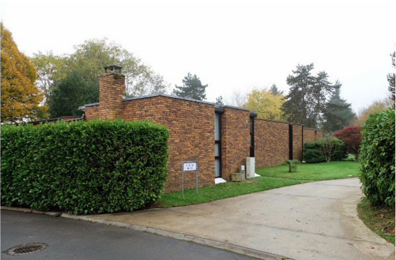
Fig. 9 : Photographie de la résidence « Ascot », à Roissy-en-Brie, réalisée par les architectes Philippe et Martine Deslandes entre 1965 et 1971. Ce projet compte 73 logements disposés en grappe autour d'un espace collectif délimité par des cheminements piétons. Source : Photos http://astudejaoublie.blogspot.com/2014/11/roissy-en-brie-residence-ascot-deslandes.html
