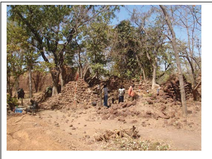
Photo C : vu du vestibule à partir de l'angle sud est. On voit l'éboulement dans les angles sud-est et sud-ouest
