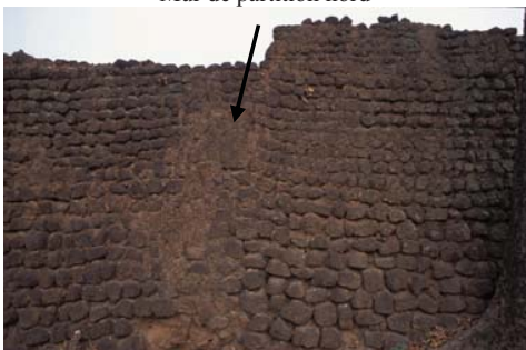
La discontinuité dans la maçonnerie de la partie Nord du rempart Est semble indiquer que cette partie de mur a été reconstruite
