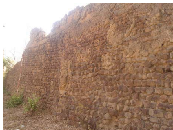
B. mur d'enceinte à l'Ouest du secteur 7. 5 m de haut, mur se terminant par des colombins d'argile, et enduits sur les façades
