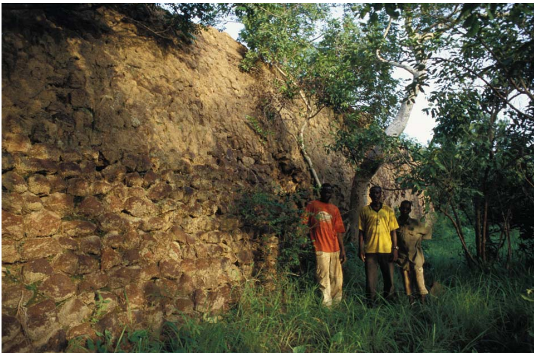
Façade Ouest du rempart principal
