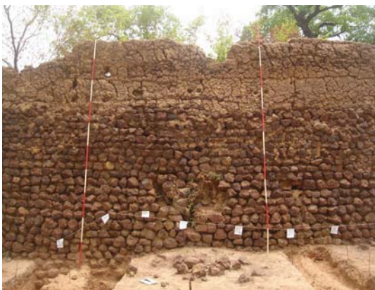
Face intérieure de la muraille avec trous pour poutres
