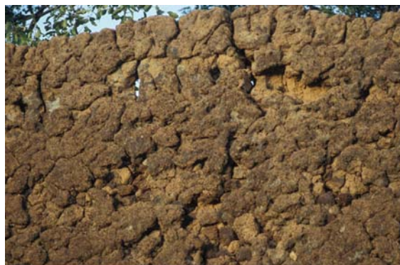
Détail du haut du mur, bâti en bauge
