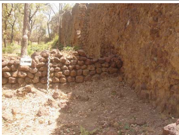
C. intersection en angle droit entre mur Est du secteur et mur de partition
