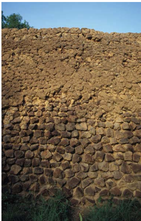
Vue d'ensemble sur un mur type
