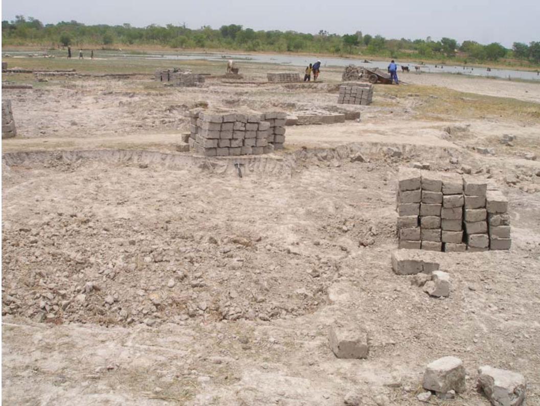
Le barrage de Loropéni comme sœur jumelle de la paléo mare ...
