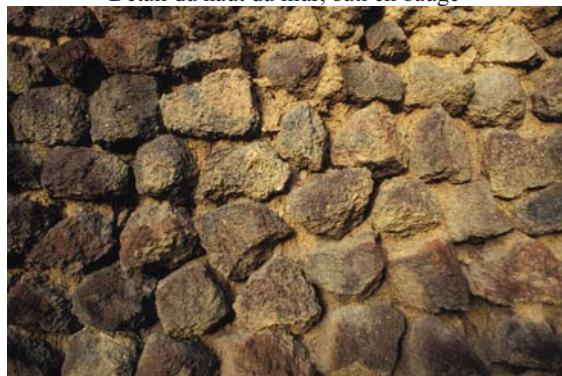
Détail de la maçonnerie de pierre
