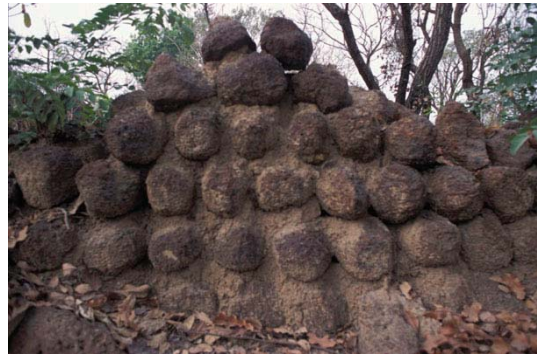
Mur réalisé avec des moellons de forme ovoïde (Centre-Ouest)
