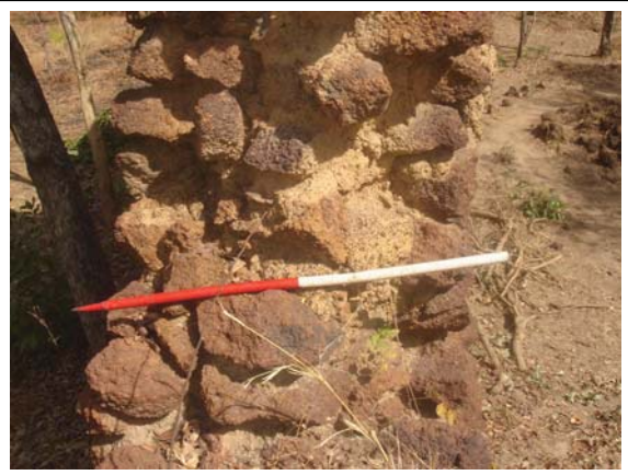
F. Vue de l'épaisseur de la muraille (1m). On distingue entre les pierres le liant en argile
