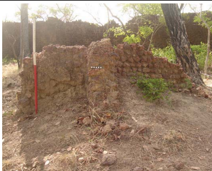
C. Pan de mur à l'est du secteur. On remarque l'intersection en angle droit et la taille modeste
