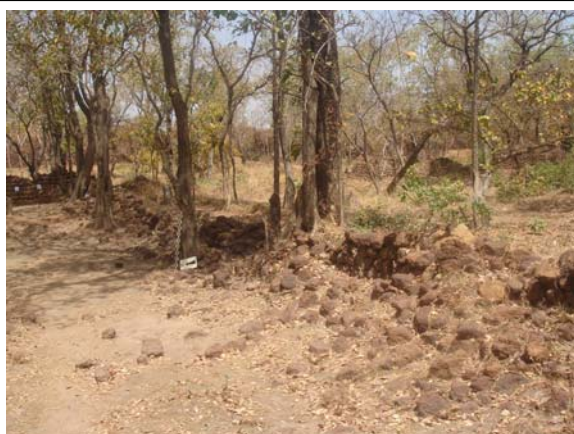
E. Mur délimitant le secteur à l'est
