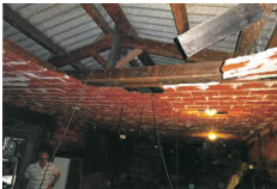
Fig 13. Effondrement de plafond d'une grange – vulnérabilité A - Photo © Billaud & Google earth.
