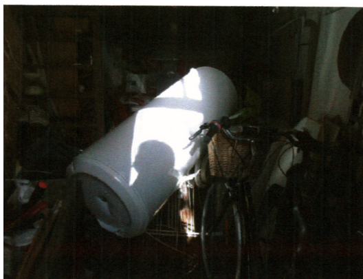
Fig. 28 – Chute d'un chauffe-eau électrique.
