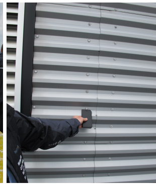
Fig. 45 - déplacement des bâtiments à la hauteur des joints de dilatation.
