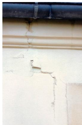
Fig. 25 – Fissures sur mur de façade (vulnérabilité A).
