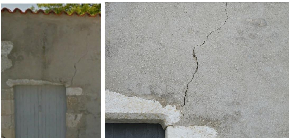
*Fig.37 – Fissuration déclarée suite au séisme (image de gauche Google 2013, image de droite 12 mai 2016).*
