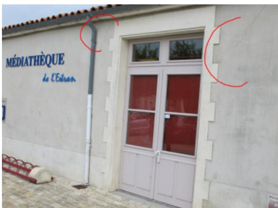
Fig. 24 – Fissures fines sur mur porteur (vulnérabilité A).
