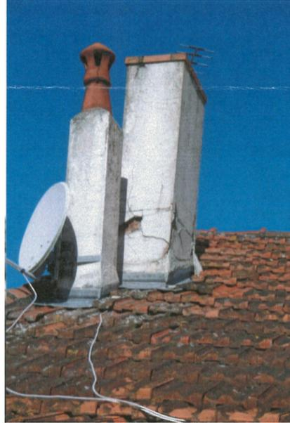
*Fig. 31 – Fissuration et éclatement de crépis de cheminée.*
