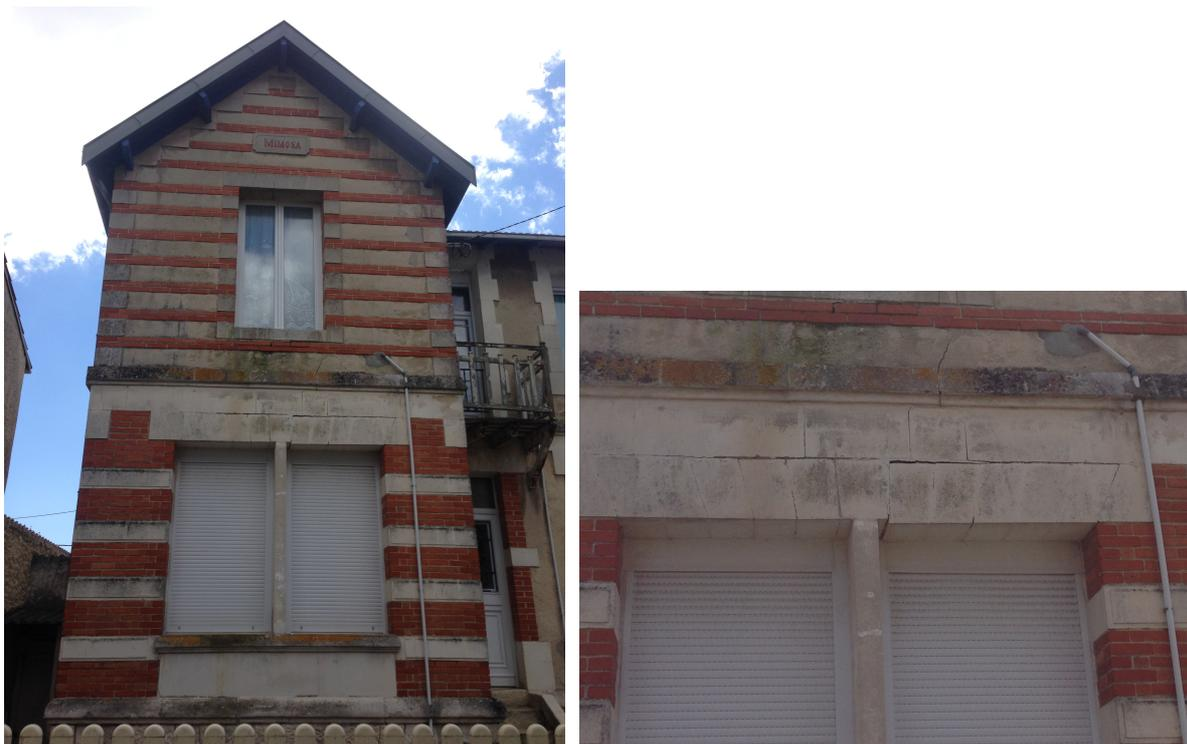
*Fig.13 – Détachement de pierre composant le haut d'un encadrement de fenêtre – rue des dunes.*
