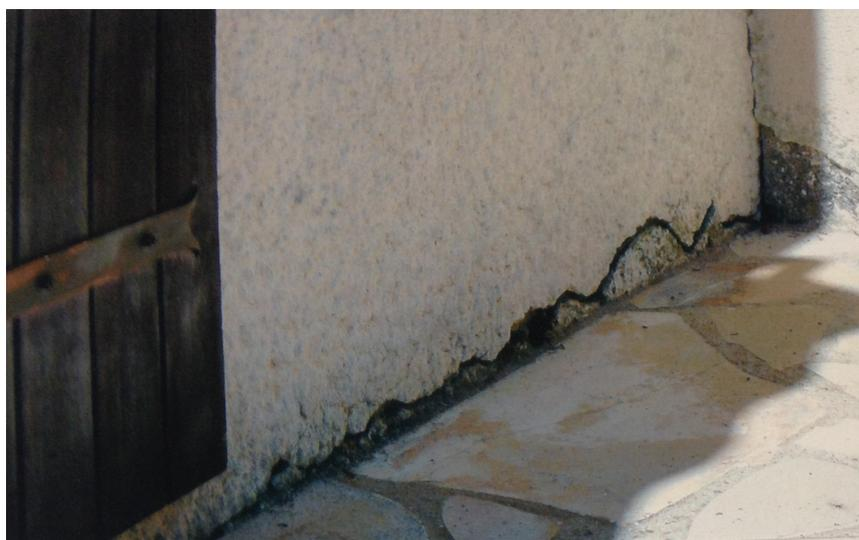
Fig. 12 – Endommagement préexistant sans rapport avec les effets sismiques (Angoulins).
