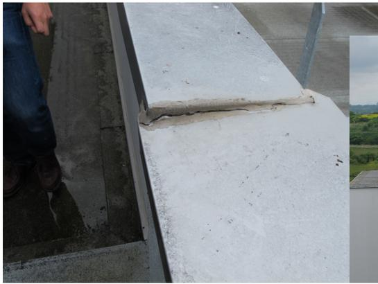
Fig. 44 – Endommagement du joint en silicone.
