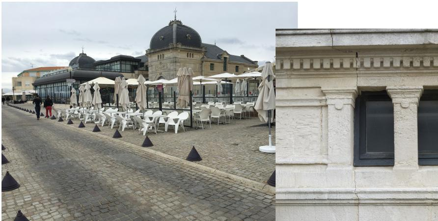
*Fig. 16 – Fissure fine de la façade du Casino de Chatelaillon suite à un mouvement principalement E-W*
