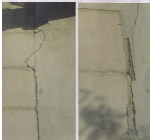
Fig. 11 – Endommagement déclaré après le séisme.
