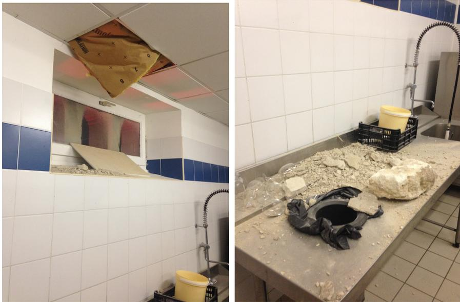
*Fig. 18 - Chute d'une pierre du mur du Casino dans la cuisine.*
