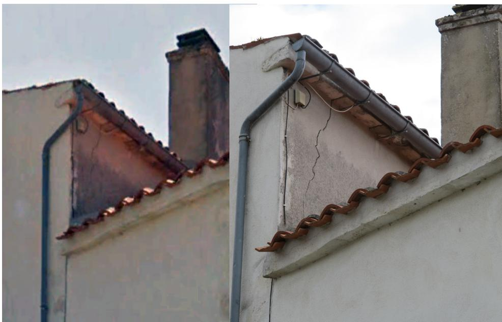
*Fig.36 – Fissuration déclarée suite au séisme
