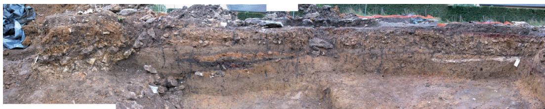
Figure n°169. Coupe et photoplan de la coupe du sondage 13 : mise en évidence des vestiges d'ateliers de la phase A (PL. DL)
