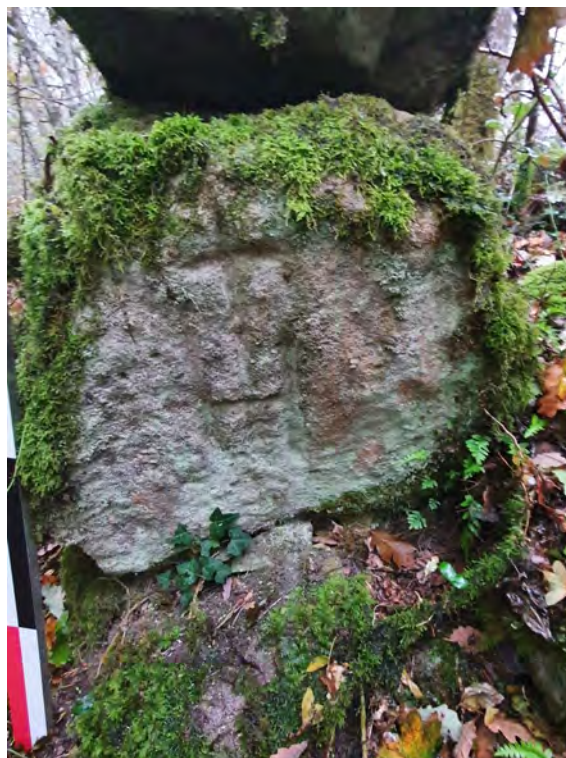
Figure 10: Un monogramme est gravé sur un bloc monolithe à l'occasion d'un passage dans le mur
