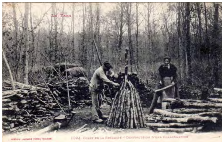
Figure 33: En Grésigne, construction d'une charbonnière
