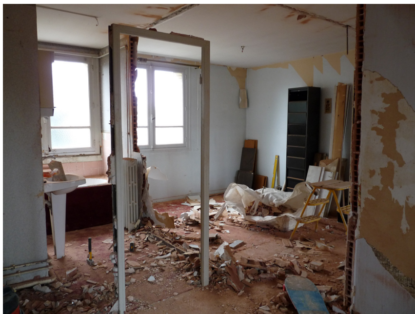
Figure 12 : L'appartement « évidé » pour restructuration intérieure (Belle Paule)
