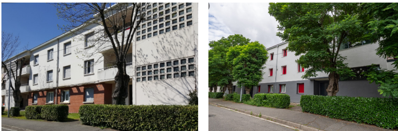
Figure 23 : La réhabilitation énergétique efface les caractéristiques identitaires des immeubles de Pampus - source : Toulouse Métropole Habitat
