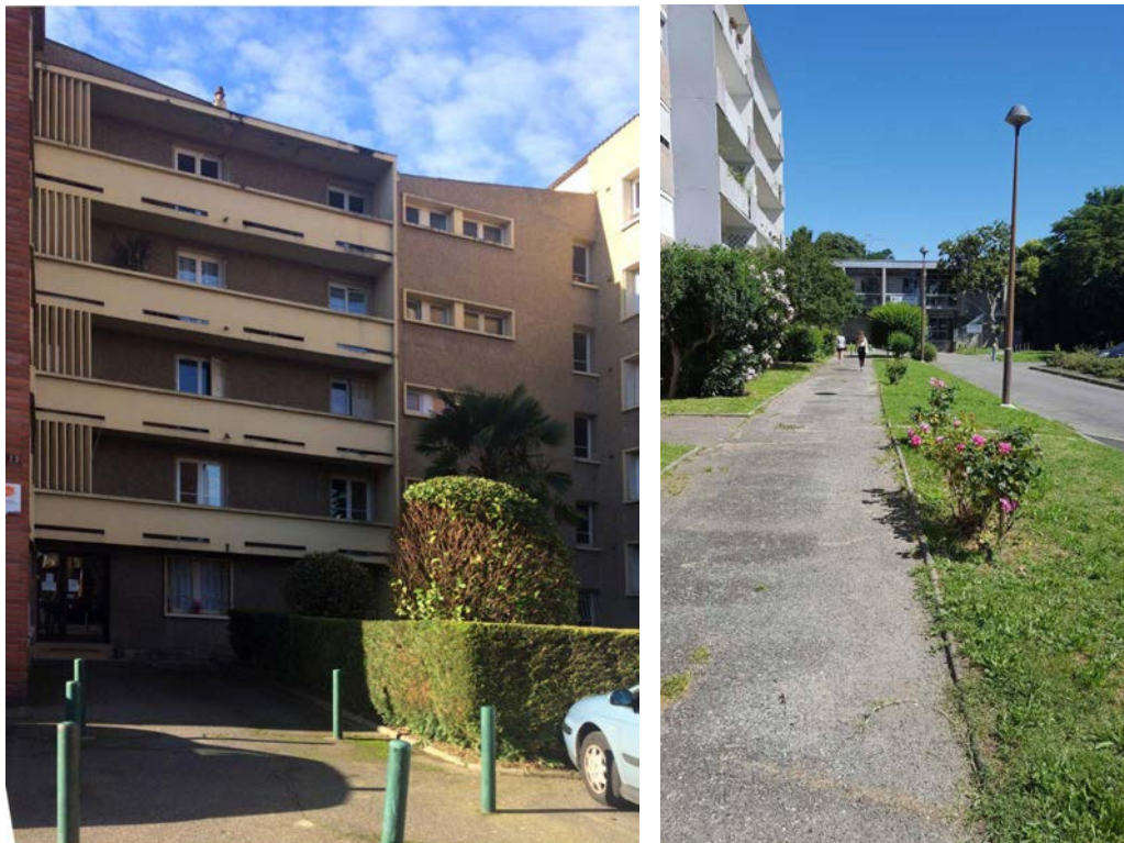
Figure 8 : Eloignement des entrées d'immeubles des voies et parkings à Belle Paule et à Ancely - source : DRIOUECHE, juin 2018
