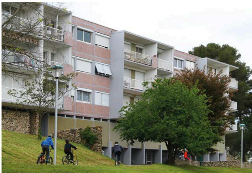
Figure 3.c : Ancely (1963-1973), Henri Brunerie architecte
