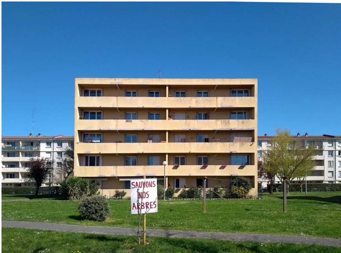
Figure 8 : Mécontentement des habitants de Papus pour le laisser-aller dans l'entretien des espaces verts - source : COURBEBASSE mars 2019
