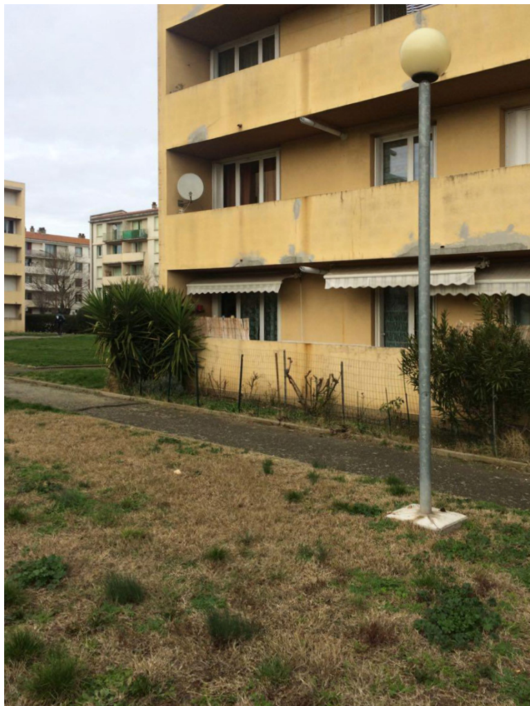
Figure 20 : Immeuble rue de la Touraine, dernière phase du projet - source : DRIOUECHE, janvier 2018
