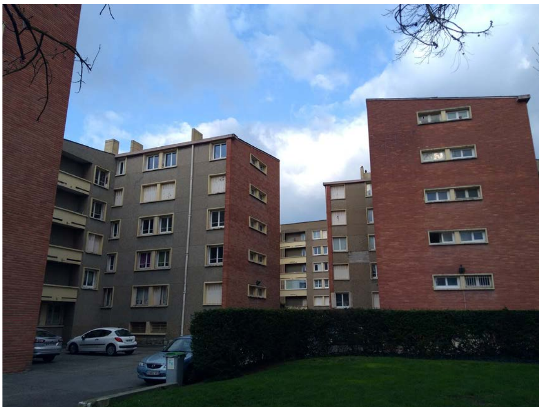
Figure 3 : L'unique espace de pleine de terre de la Belle Paule. Par manque de place à l'extérieur de la cité, les résidents n'hésitent pas pénétrer leur(s) voiture(s) dans les coeurs d'îlots et à stationner sous leurs propres fenêtres
