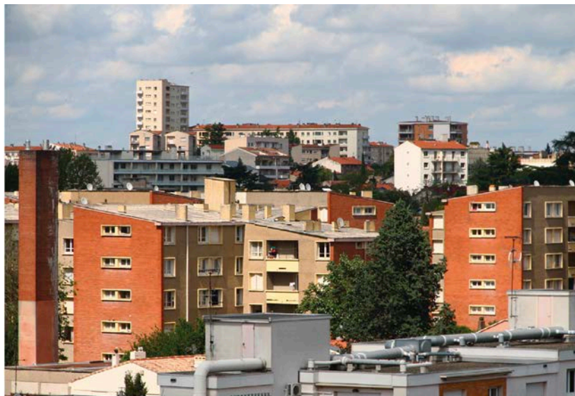
Figure 3.b : la cité Belle Paule (1953-1956), Robert Valle architecte
