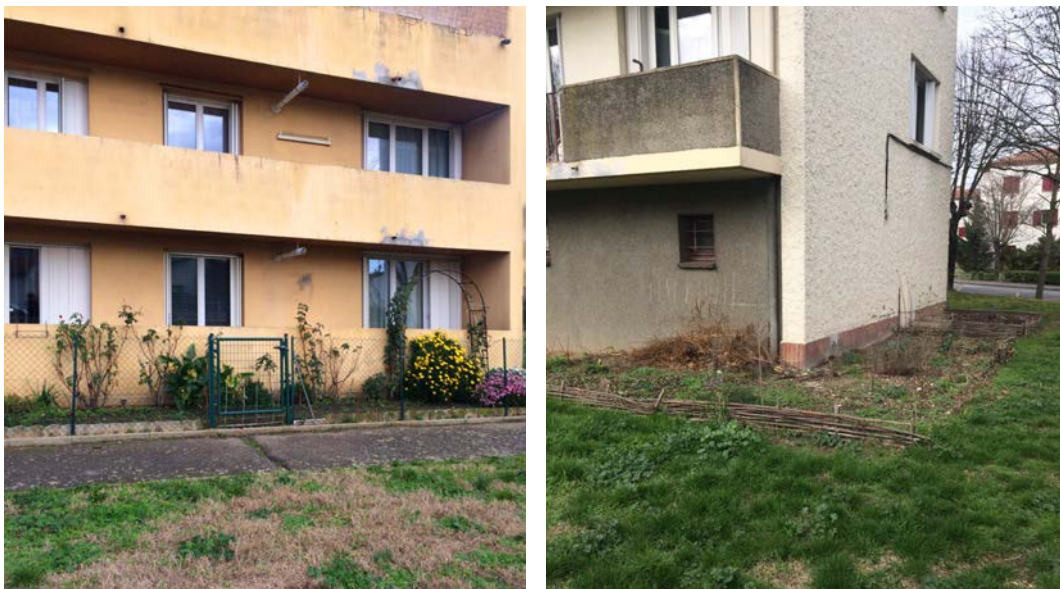
Figure 21 : Appropriation des rez de jardins- source : DRIOUECHE, janvier 2018
