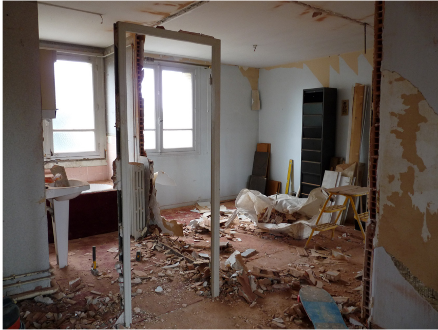
Figure 12 : L'appartement « évidé » pour restructuration intérieure (Belle Paule)
