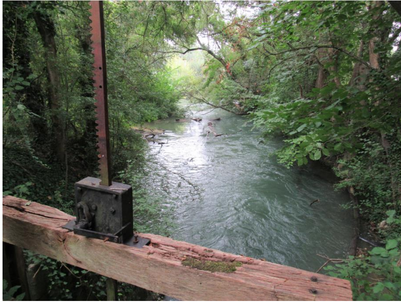
Figure 7. Vue depuis la vanne permettant la connexion entre le chenal et la Seine. On note la turbulence limitant localement la sédimentation.
