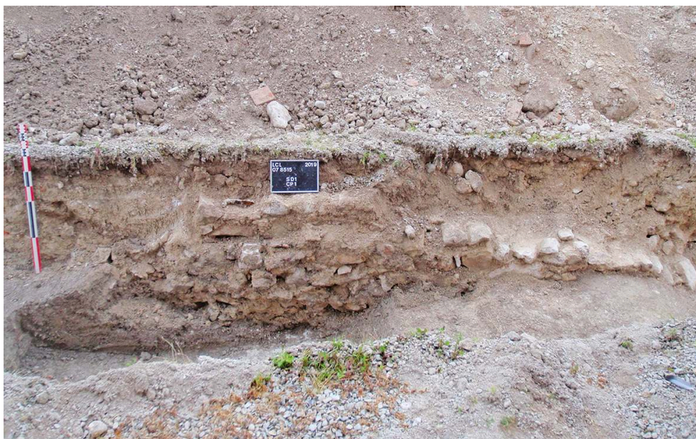
Fig. 14 – Mur pignon de la nef de l'état 6 (cl. C. Roms).
