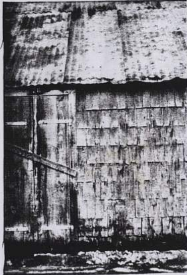
Case en bardage de planches simple
