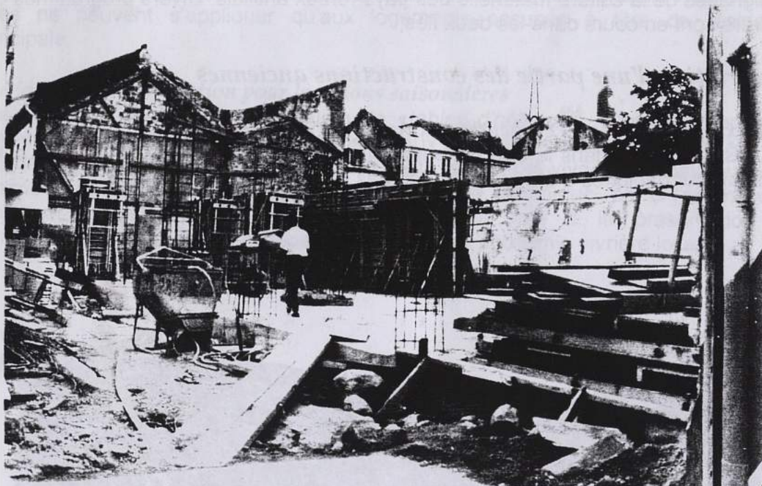
Figure 109 Chantier de démolition d'un magasin colonial à Fort-de-France Photo A.H. 1991
