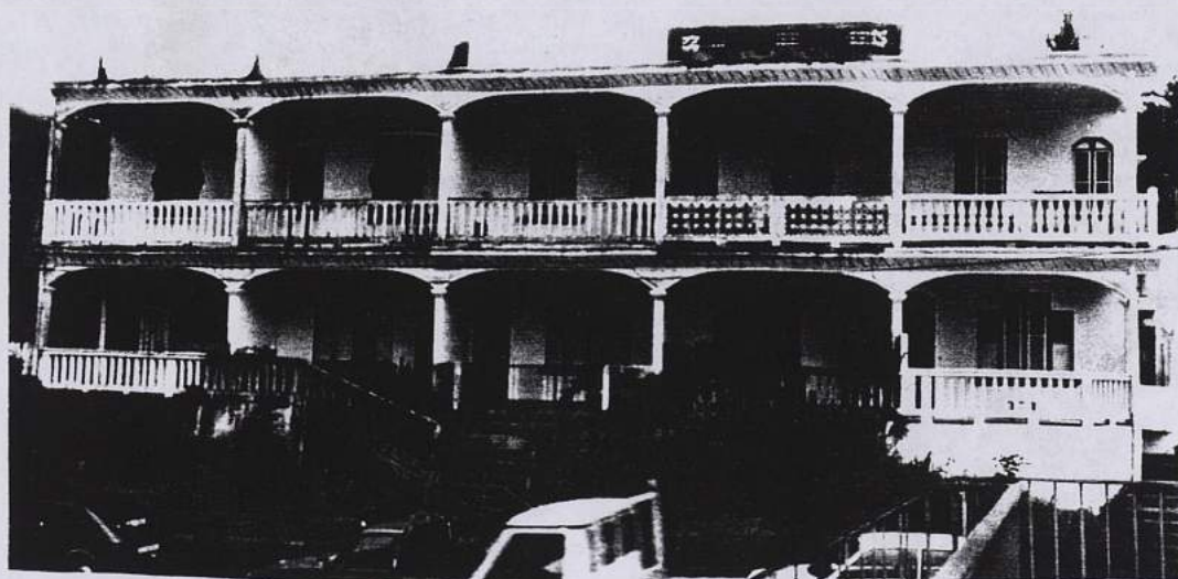
Figure 125 Un immeuble Boulevard Adhémar Modock à Fort-de-France Photo A.H. 1991
