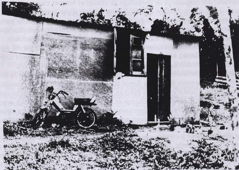
La case en fibrociment est simplement posée au sol Photo A.H.
