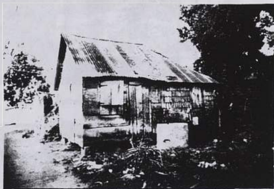
Figure 60 La case élémentaire guadeloupéenne Photos A.H. 1991 - 1994 Posée sur des pierres, la case s'ouvre en pignon; ici ce module simple est prolongé à l'arrière par une pièce.
