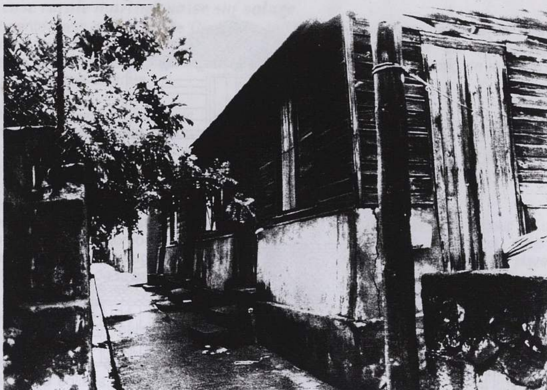
Cases en bardage bois sur un haut solage en maçonnerie.
