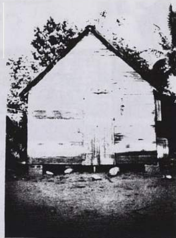
Figure 60 La case élémentaire guadeloupéenne Photos A.H. 1991 - 1994 Posée sur des pierres, la case s'ouvre en pignon; ici ce module simple est prolongé à l'arrière par une pièce.
