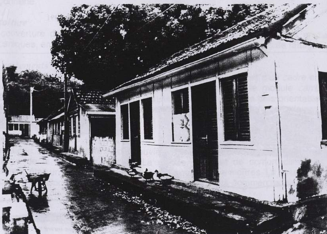
Cases en maçonnerie enduite avec solage bas
