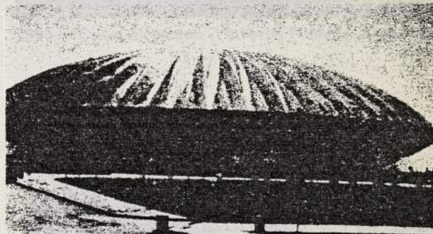
1960 — Chantier de construction en voile mince « in situ ». « Assembly Hall ». Illinois, U.S.A. Harrison et Abramovitz.
