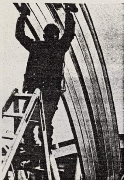
Montage d'un élément de couverture de grande longueur en tôle d'acier galvanisé nervuré et cintré.
