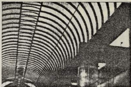
Polycarbonate transparent | cintré à froid.
