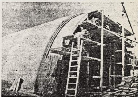
1944 — Construction d'une voûte à l'aide de fusées céramiques. Jacques Couelle (France).
