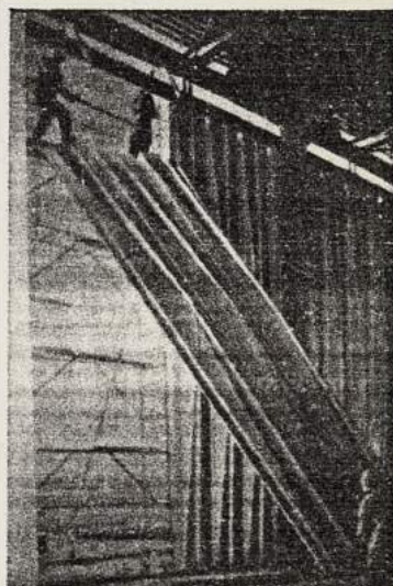
Montage d'éléments de vêtements en aluminium. Normko & Silberkuhl (R.F.A.).
