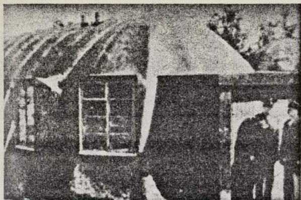
1943 — Construction d'abris militaire à l'aide de béton et de toile de jute. Major J.H. de Waller.
