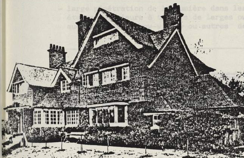
p. 344 "WOODSIDE, GREAT STANMORE" du même architecte également
