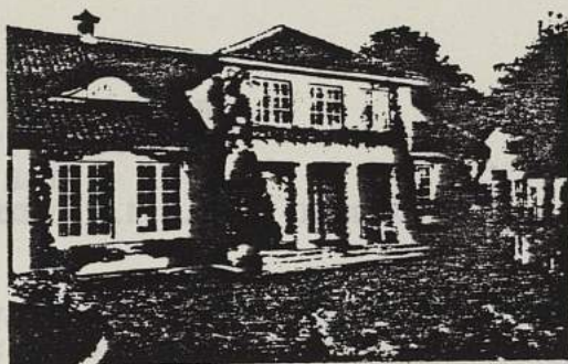
p. 200 "MAISON DES ARCHITECTES EUX-MEMES"
