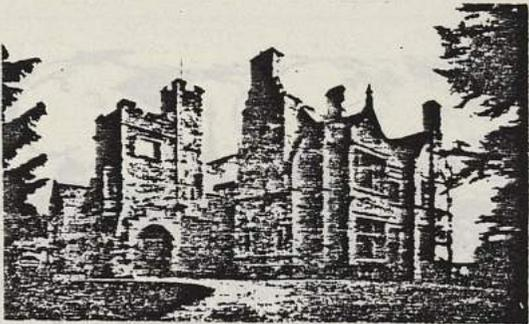
C'est une construction en pierres de BROTHAY, pierre de couleur bleu gris foncé provenant de carrières situées à cinq milles. Les encadrements de fenêtre et chaînages d'angle sont en grès de PRUDHAM de couleur chamois, la toiture est couverte d'ardoises de BUTTERMERE vert gris foncé.
