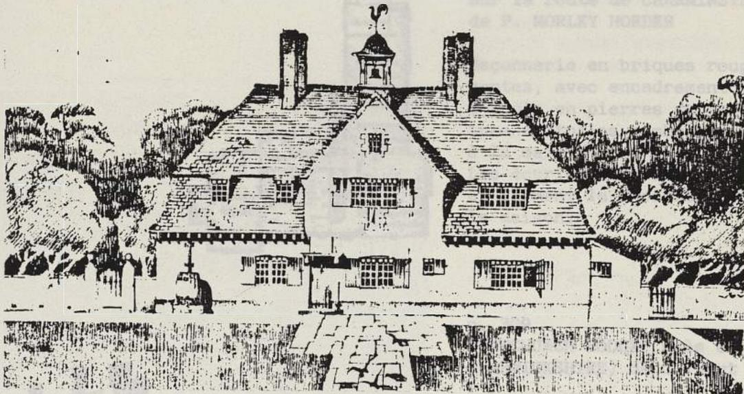
bâtiment élevé à l'emplacement d'une maison détruite par un incendie. Construction en briques couleur sable couvertes d'ardoises du WESTMORELAND. Intérieur, chaînage d'angle et corniche en pierre blanche de
