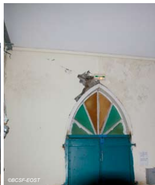
Fig. V-59 : Sainte-Marie, église Mornes des Esses (vue intérieure).
