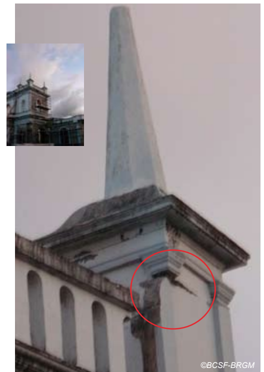
Fig. V-23 : Le Lorrain Eglise de 1743 en cours de restauration.
