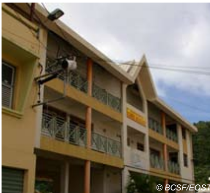
Fig. V-186 : Rivière Pilote - Bibliothèque 6 vulnérabilité C - dégâts de niveau 1.
