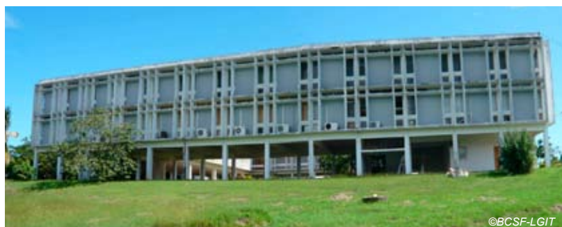
Fig. V-88 : La Trinité, bâtiment de l'AFPA - bâtiment L1 - (RC transparent).
