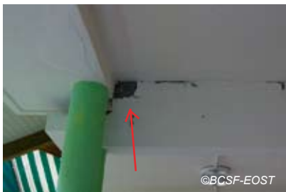
Fig. V-44 : Le Marigot - Affaissement de la terrasse d'un restaurant situé en bord de talus ayant engendré des mouvements importants sur la structure.
