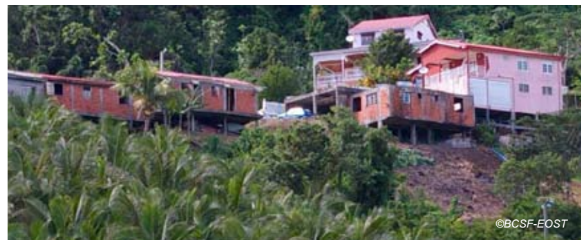
Fig. V-7 : Exemples de constructions vulnérables implantées sur un terrain en pente et comportant un niveau transparent
