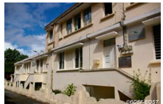
Fig. V-10 : Grand-Rivière, école mixte élémentaire (vulnérabilité B/C - dégâts de niveau 2).
