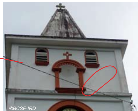
Fig. V-73 : Fonds-Saint-Denis Eglise - fissuration du clocher.
