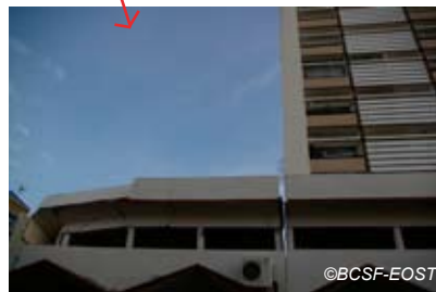
Fig. V-123 : Fort-de-France Immeuble Plein Ciel, façade sud.
