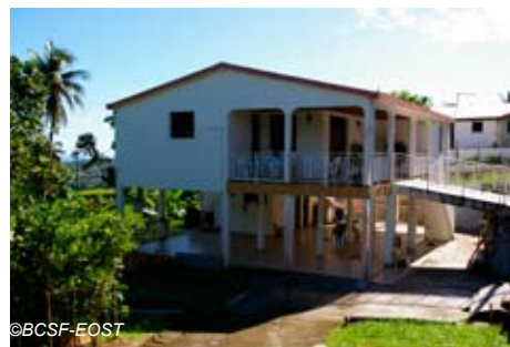
Fig. V-31 : Ajoupa-Bouillon, maison individuelle très vul-nérable ne souffrant d'aucun dégât -selon interview de la propriétaire (asymétrie de plan et RDC transparent).
