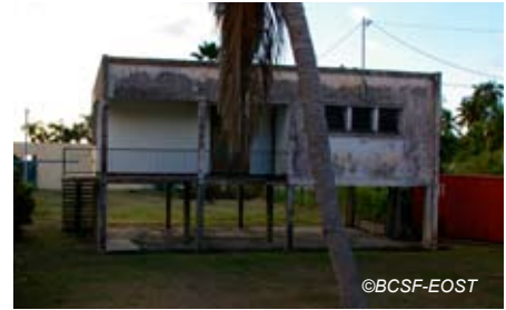
Fig. V-102 : Le Carbet - maison sur pilotis (niveau transparent) - sans dégât.
