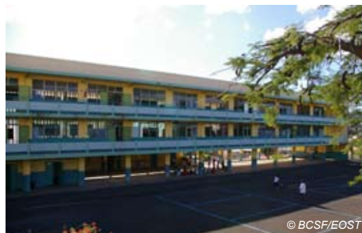
Fig. V-163 : St.-Esprit - Ecole mixte B (RC partiellement transparent) sans dégât.
