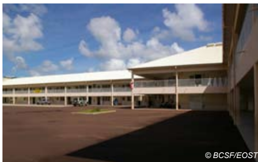
Fig. V-189 : Rivière Pilote - Ecole maternelle Manikou - quelques dégât de niveau 1.
