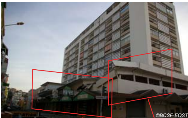
Fig. V-122 : Fort-de-France Immeuble Plein Ciel, façade ouest.
