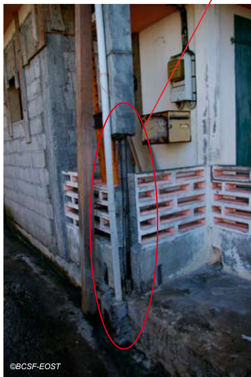
Fig. V-16 : Grand-Rivière, détail du pilier.
