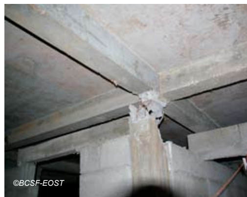
Fig. V-4 : Sainte-Marie - Rupture par effort tranchant d'un poteau court suite à une maçonnerie de mur en blocs de béton non jointive avec les poutres du 1 er étage.
