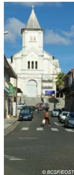
Fig. V-161 : St.-Esprit - Eglise (sans dégât).
