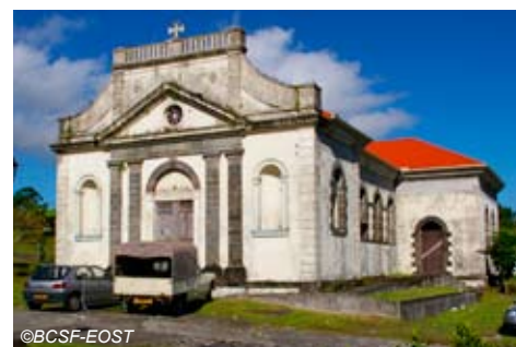
Fig. V-33 : Ajoupa-Bouillon - église (sans dégâts).
