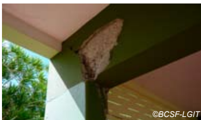
Fig. V-141 : Le Lamentin, école primaire des Roches Carrées.
