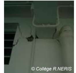
Fig. V-208 : Le Marin - lycée Raymond Néris, bâtiment D.
