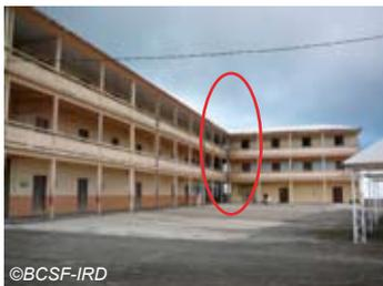
Fig. V-26 : Le Lorrain, école Léon Cécile Carabin, dégâts liés à l'entrechoquement des bâtiments;
