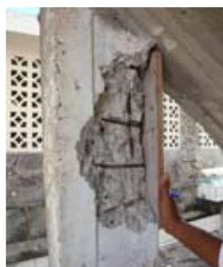
Fig. V-182 : Le Diamant, école du Bourg - éclatement de béton de couverture.
