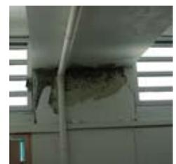
Fig. V-204 : Eclatement de béton de couverture.
