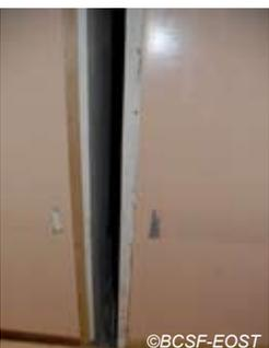
Fig. V-84 : La Trinité - (CH L.D), joint de dilatation.
