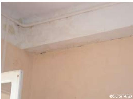
Fig. V-19 : Basse-Pointe - réfectoire - fissure fine entre structure et mur de remplissage.
