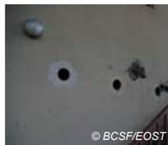
Fig. V-201 : Le Marin, presbytère - éclatement de mur en maçonnerie d'élément préfabriqués.
