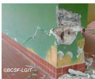
Fig. V-142 : Le Lamentin, école primaire des Roches Carrées, éclatement du béton de couverture du voile longitudinal.
