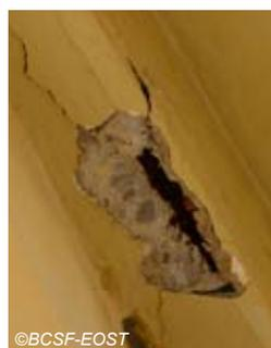
Fig. V-65 : Eclatement de béton sur élément corrodé.
