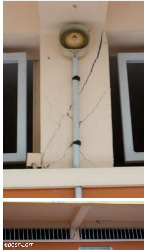
©BCSF-LGIT Fig. V-78 : Gros-Morne - école La Fraîcheur fissure en X, effet "poteau court".
