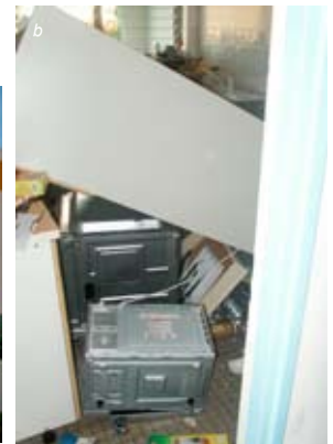
Fig. V-195 : Le Marin - 7 ème étage d'un immeuble de la cité scolaire - chute de mobilier et d'électroménager, chauffe-eau électrique arraché de sa fixation.
