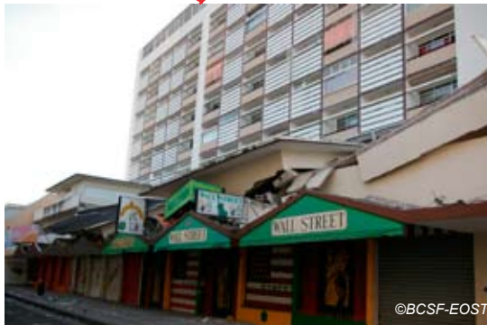
Fig. V-124 : Fort-de-France Immeuble Plein Ciel, façade ouest, effondrement du parking.
