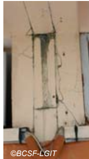
©BCSF-LGIT Fig. V-77 : Gros-Morne - école La Fraîcheur dégât au joint de dilatation.
