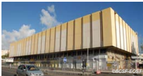
Fig. V-135 : Fort-de-France - Centre de tri (La Poste).
