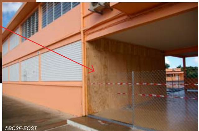
Fig. V-43 : Le Marigot - Collège du Marigot, effondrement d'un mur de cloisonnement.
