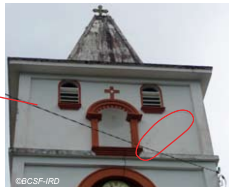
Fig. V-73 : Fonds-Saint-Denis Eglise - fissuration du clocher.
