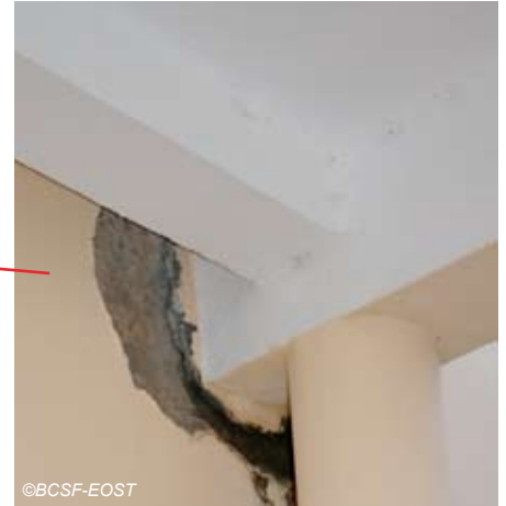
Fig. V-40 : Infiltration préexistantes.
