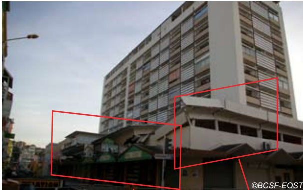
Fig. V-122 : Fort-de-France Immeuble Plein Ciel, façade ouest.
