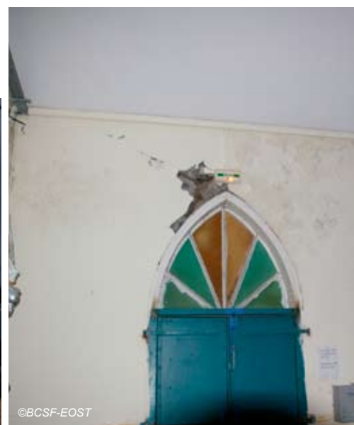
Fig. V-59 : Sainte-Marie, église Morne des Esses (vue intérieure).
