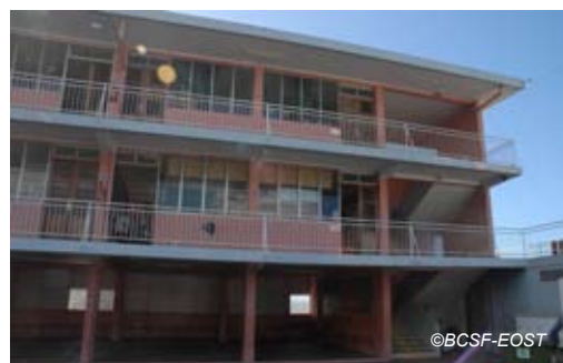
Fig. V-116 : Case-Pilote, école primaire Saint-Just Orville - RC partiellement transparent.
