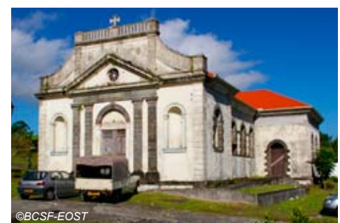
Fig. V-33 : Ajoupa-Bouillon - église (sans dégâts).
