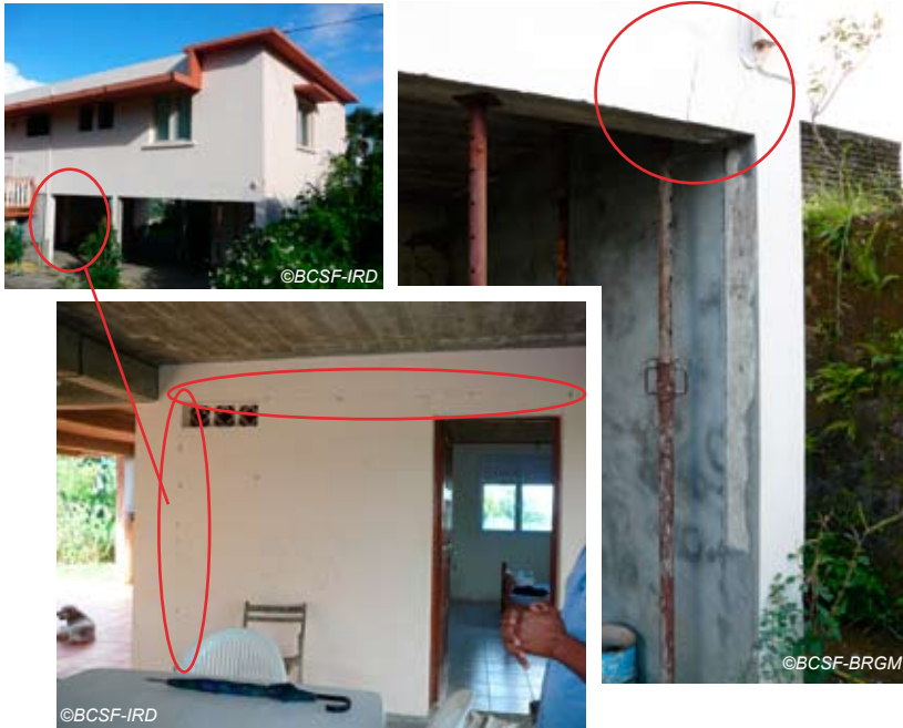
Fig. V-24 : Le Lorrain, lieu-dit Fonds Gens Libres – maison individuelle. RC+1.
