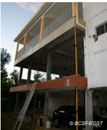
Fig. V-211 : Transparence et asymétrie de la structure.
