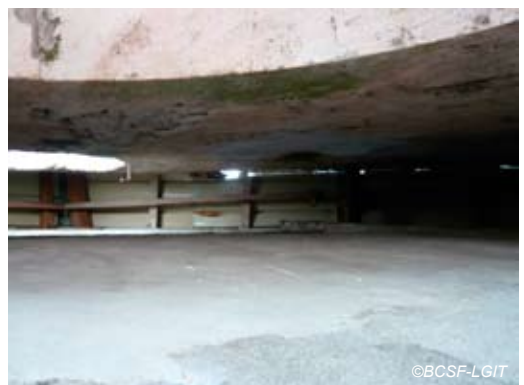
Fig. V-75 : Gros-Morne, détachement de la façade de l'église (prise de vue en contre-plongée).
