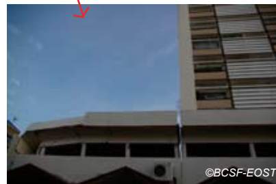
Fig. V-123 : Fort-de-France Immeuble Plein Ciel, façade sud.
