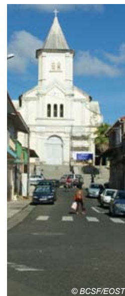
Fig. V-161 : St.-Esprit - Eglise (sans dégât).
