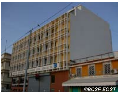
Fig. V-125 : Fort-de-France Immeuble SGBA façade est.
