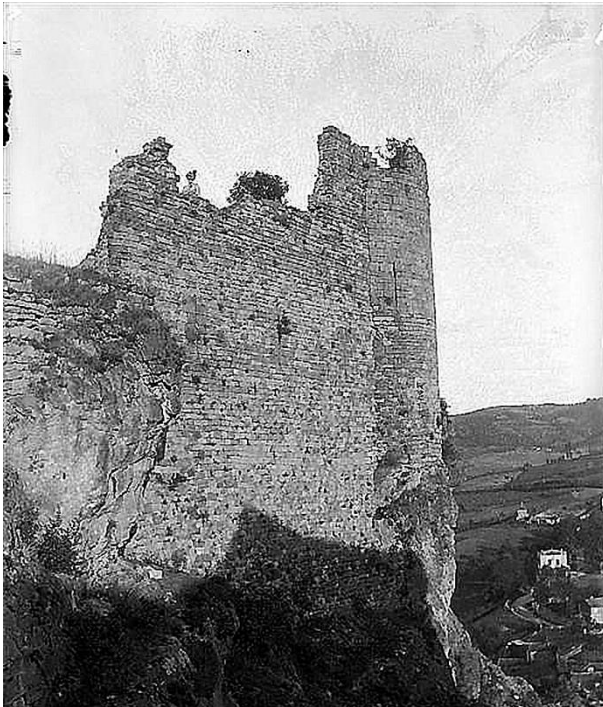
Fig. Tour et enceinte, parements externes. Absence de chaînage : la tour est postérieure à l'enceinte. Donation Amélie Galup. Image du 26 août 1897. Photo (C) Ministère de la Culture — Médiathèque de l'architecture et du patrimoine, Dist. RMN-Grand Palais/Amélie Galup
