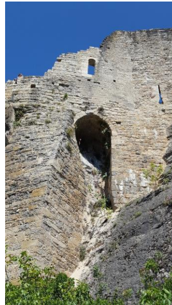
Fig. M39, voûte et contrefort. Photo Romain Valette
