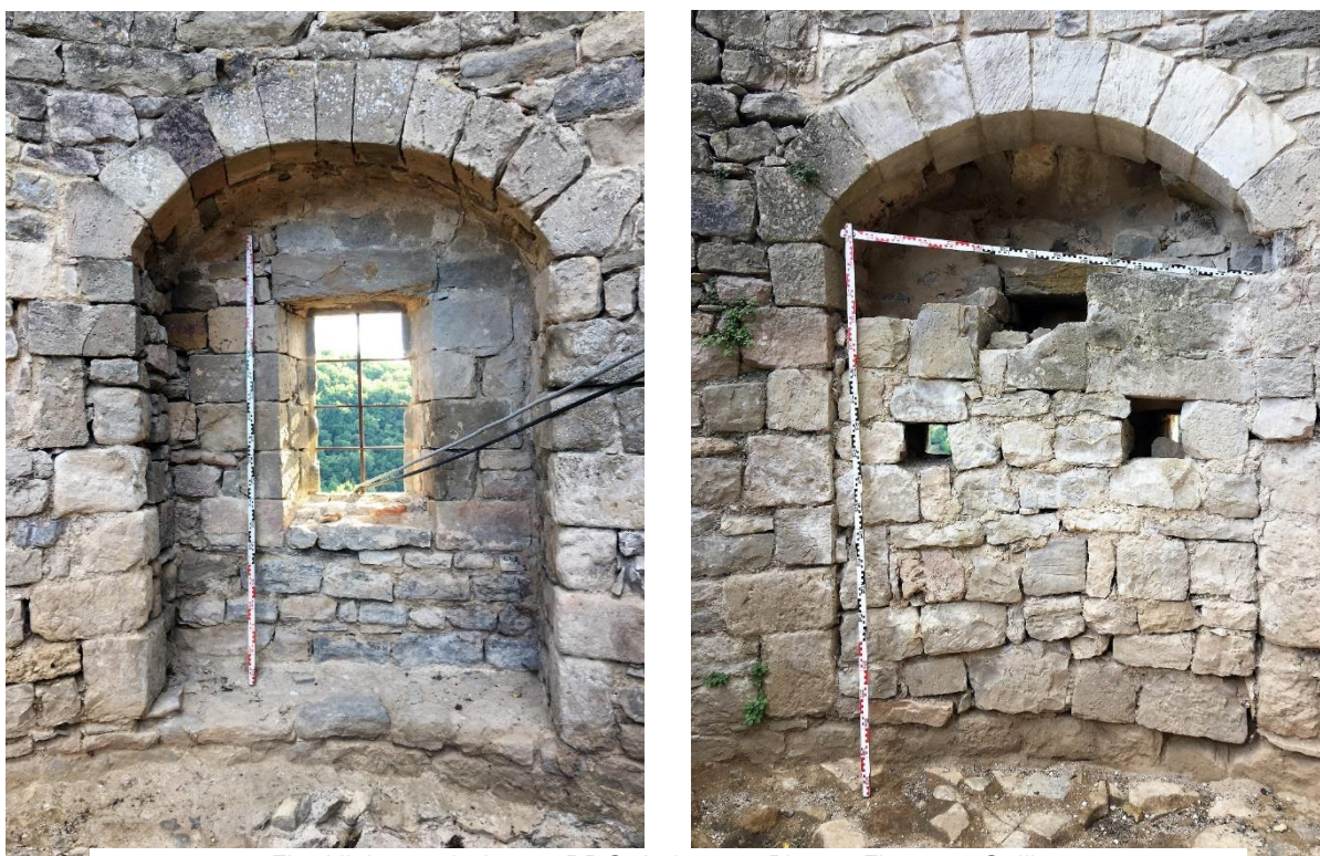
Fig. Niches et baies au RDC de la tour. Photos Florence Guillot.
