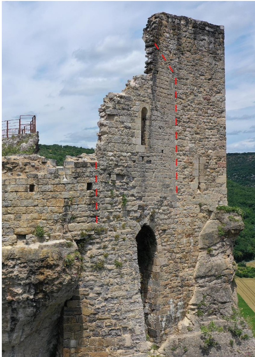
Fig. Extrémité orientale du château de Penne. On distingue les vestiges de l'église encadrée par l'enceinte (chevet plat = mur 39, situé entre les pointillés rouges). L'ouverture (baie) qui est située dans l'axe de l'autel, lui-même adossé juste derrière, a été reconstruite récemment suivant des archives iconographiques du XIXe siècle et du début du XXe siècle qui en relataient la forme et l'emplacement. Les murs d'enceinte (M38 et M40) qui entourent le mur 39 lui sont postérieurs. Photo Denis Langlois.
