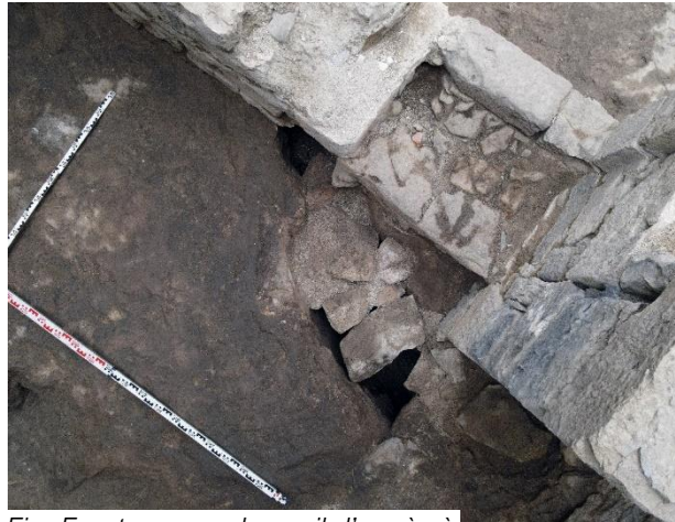
Fig. Fracture sous le seuil d'accès à la tour. Photo Florence Guillot
