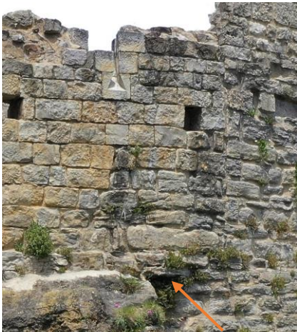
Fig. Photo Denis Langlois — évacuation de l'eau à travers M38, en zone 4.
