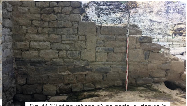
Fig. M 52 et bouchage d'une porte vu depuis la tour, M52a. Photos Florence Guillot.
