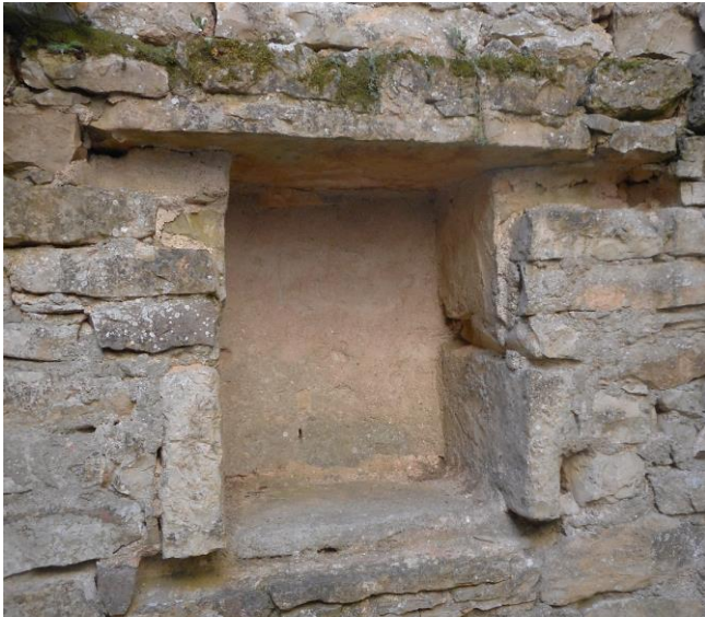
Fig. Tour de Feu – parements internes mur sud, niche et ouverture — Crédit Steeve Gamain, Aubane Priol, Aliona Troubnikoff et Gabriel Vialatte
