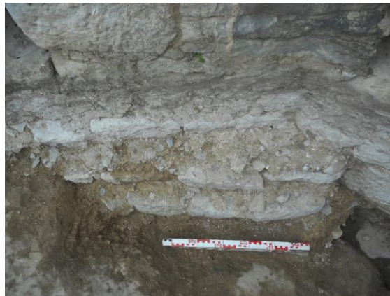
Fig. M37 parement interne en zone 3 et élargissement de la fondation.
