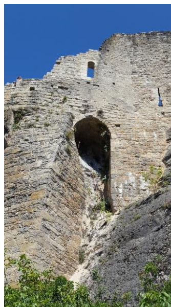
Fig. M39, voûte et contrefort. Photo Romain Valette
