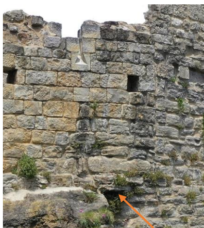
Fig. Photo Denis Langlois — évacuation de l'eau à travers M38, en zone 4.
