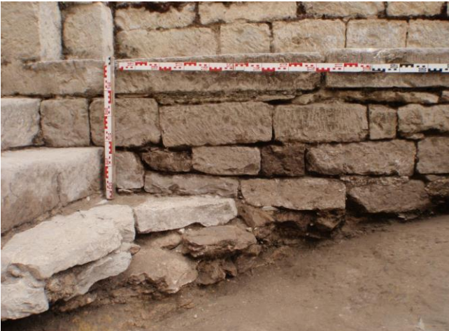
Fig. M51 (en face) et dalles de la première marche de l'accès vers la zone 1, M76 (à gauche). Photo Aubane Priol et Gabriel Vialatte
