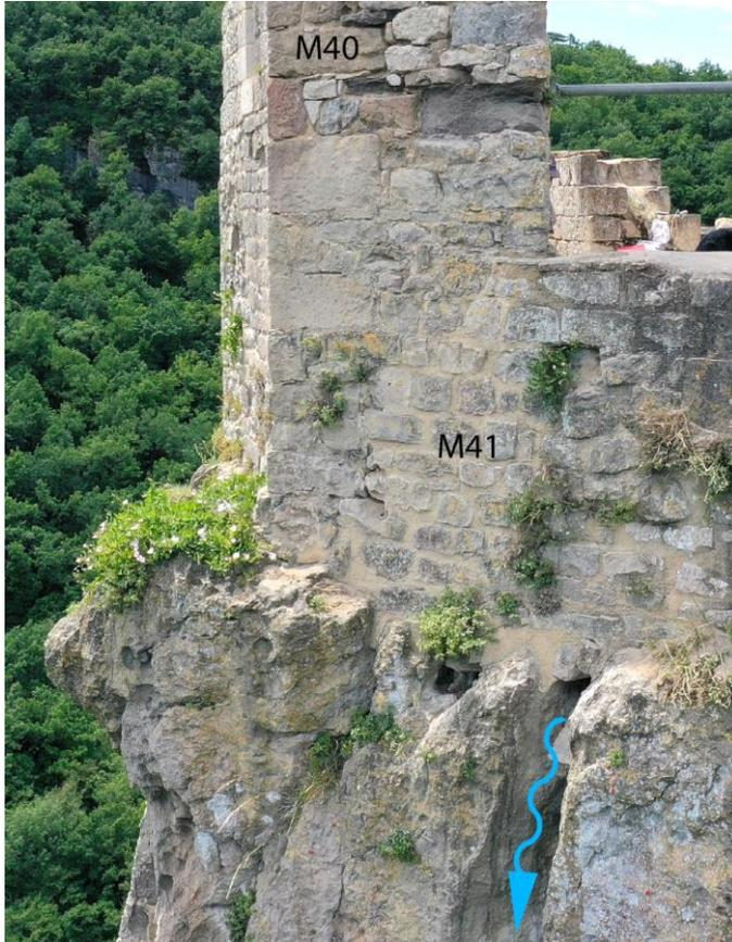
Deux grandes diaclases, d'axes grossièrement est-ouest, strient le substrat (voir ci-dessous photo de fin de fouille). Non couvertes, elles ont fonctionné en sous-tirage.
