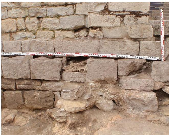
*Fig. Dégradation du M76 et insertion du muret 2.
