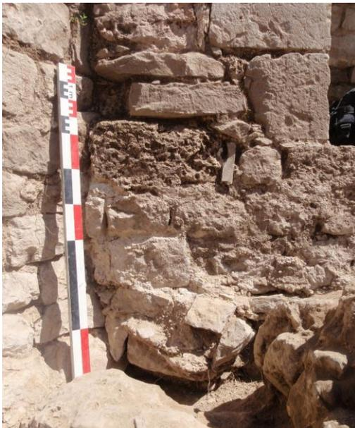
*Fig. Parement interne M41 (à gauche) / M40 (à droite). Coup de sabre et moellons en tuf.*
