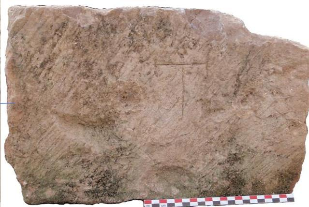
*Fig. Marque de tâcheron sur moellons utilisé dans l'encadrement du foyer. Photo Florence Guillot*
