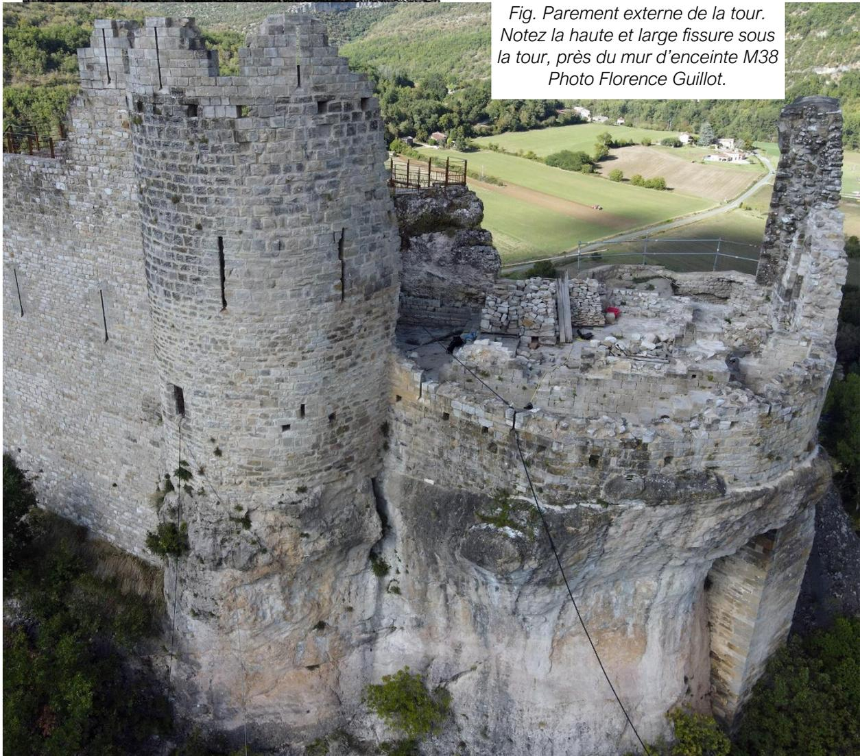
*Fig. Parement externe de la tour. Notez la haute et large fissure sous la tour, près du mur d'enceinte M38
