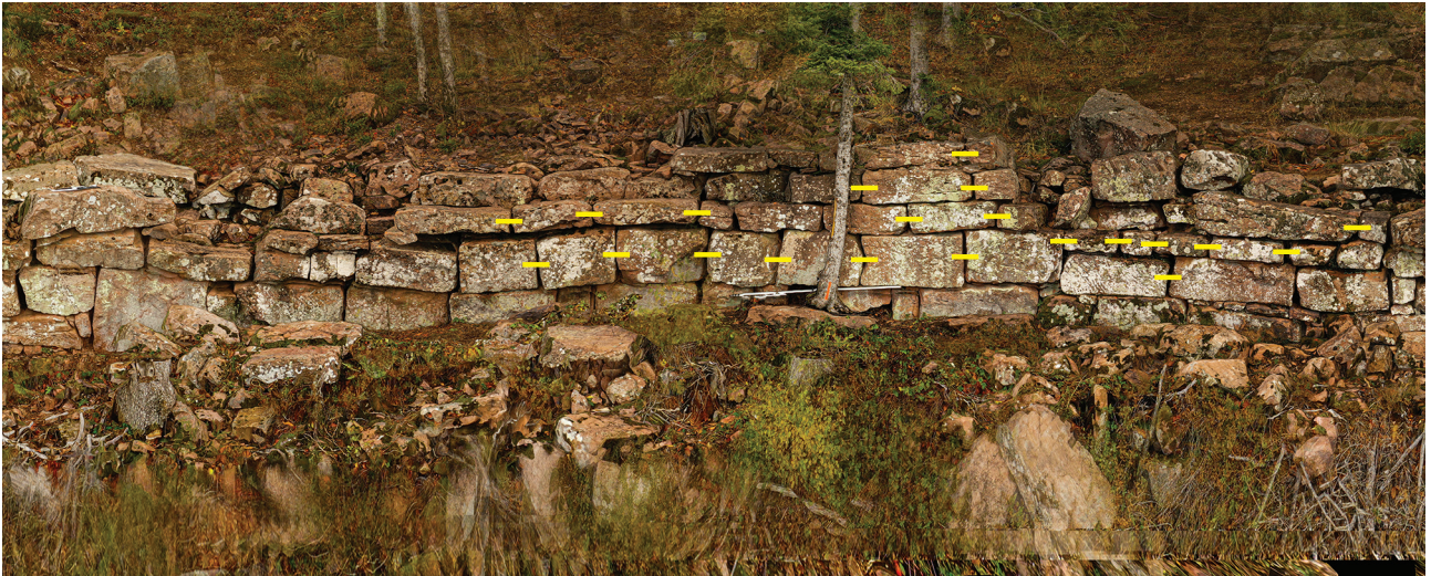
Fig. 31 : Mur païen, localisation des liaisons par tenons et mortaises (en jaune) sur les tronçons 5 et 6 L'ensemble des blocs a fait l'objet d'observation
