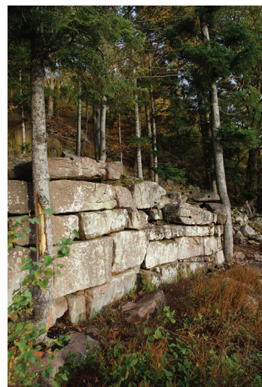
Fig. 27 : Mur païen, vues des tronçons 5 et 6 (les blocs de la deuxième assise sont installés en carreau)
