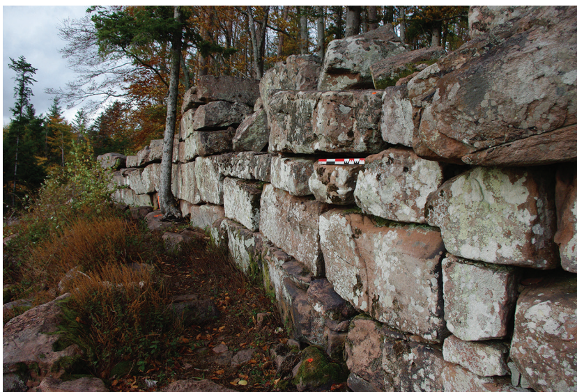
Fig. 27 : Mur païen, vues des tronçons 5 et 6 (les blocs de la deuxième assise sont installés en carreau)
