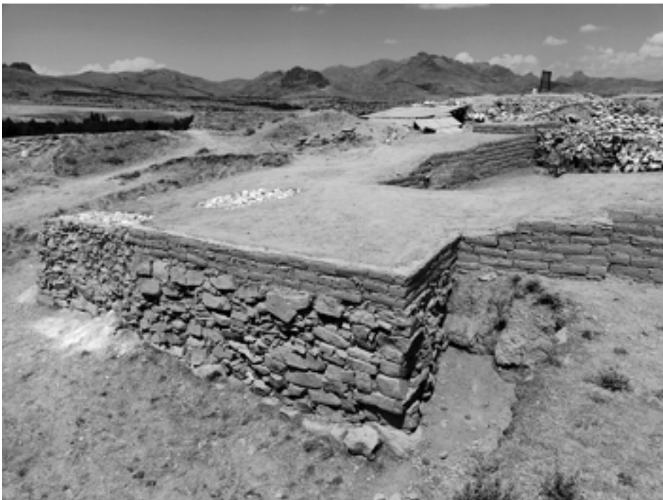
Fig. 9 Travaux de consolidation, Chantier II (Jean-François Pichonneau).
